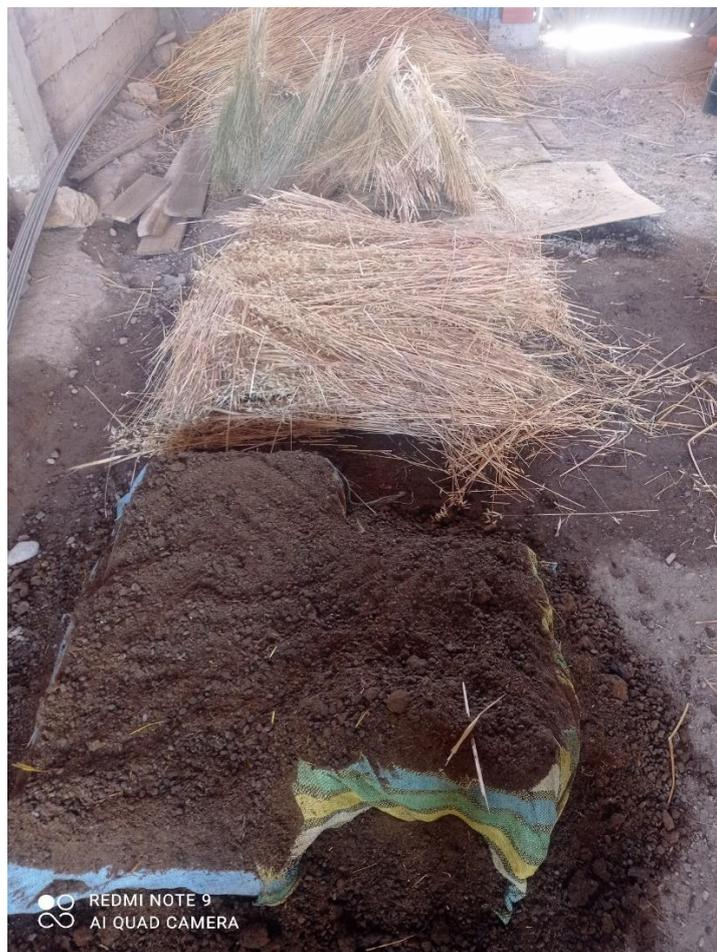
Fotografía: Proceso de protección de protección con cobertores naturales del concreto
