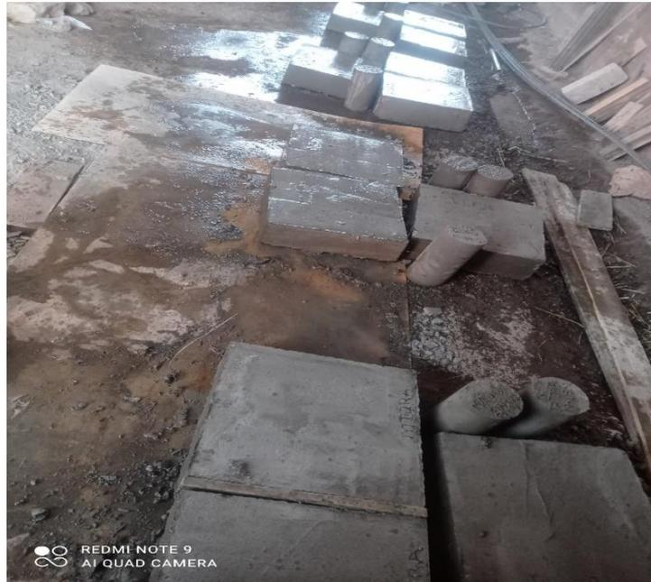
Fotografía: Curado con agua durante el desarrollo del concreto 175 kg/cm<sup>2</sup>
