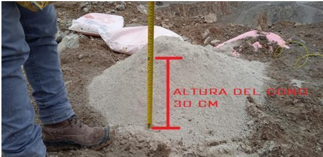
Figura 57. Altura de cono inadecuado generada post perforación en la cantera Negro Africano (Calquipa).
