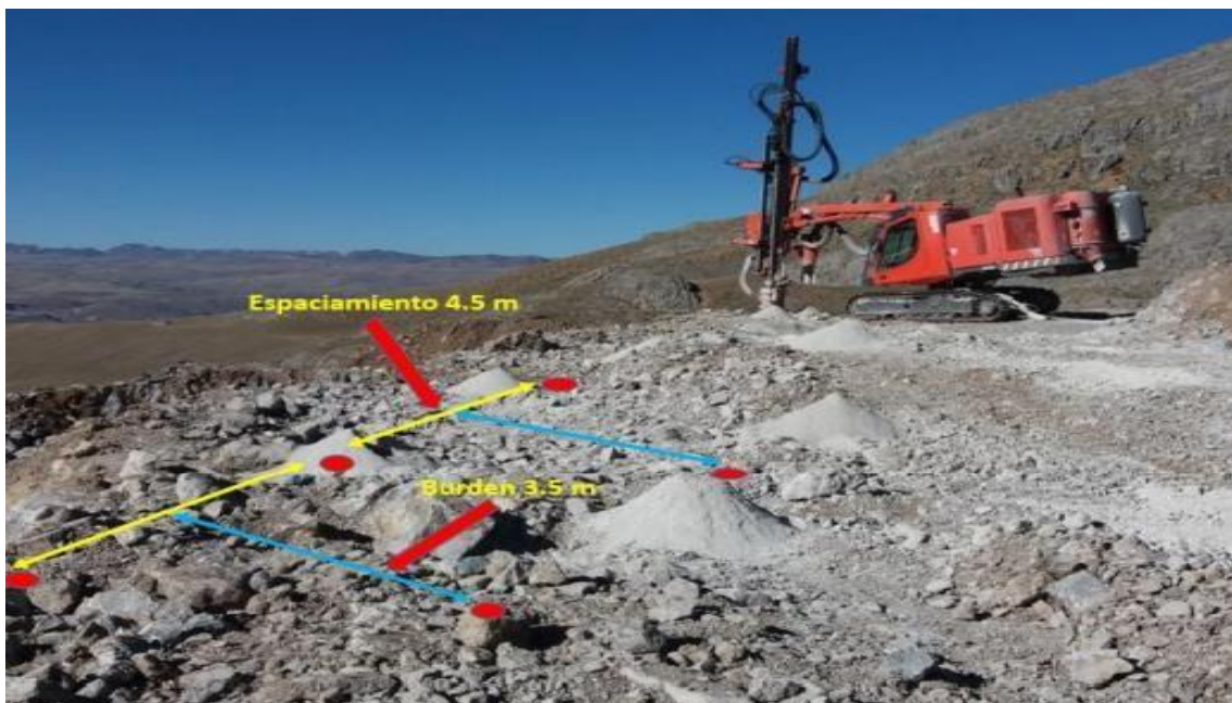
Figura 38. La máquina perforadora se encuentra realizando la perforación en la cantera el Negro Africano (Calquipa).
