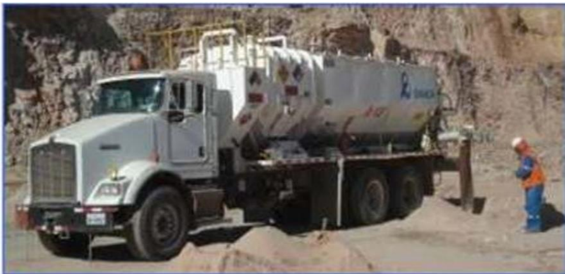
Figura 23. Primado y carguío de explosivo.
