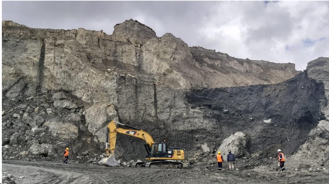
Fotografía 1. Perfil de talud N.º 01
