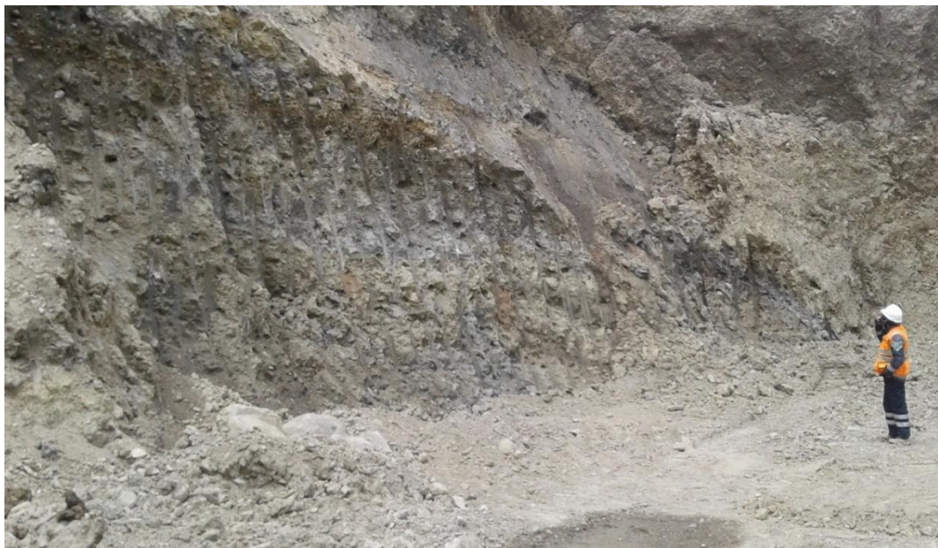
Fotografía 2. Perfil de talud N.º 02
