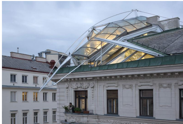
Figura 6: Vista aérea de la azotea de las oficinas de Falkestrasse.
