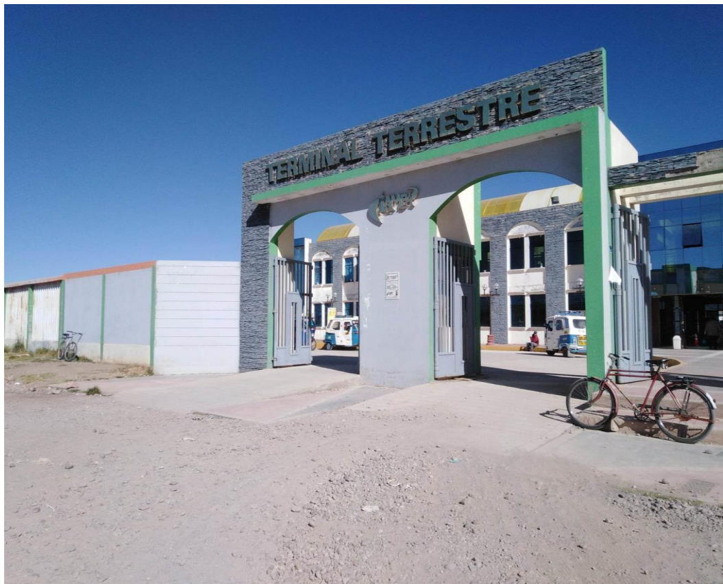
Vista de terminal terrestre de la ciudad de Lampa 2022.
