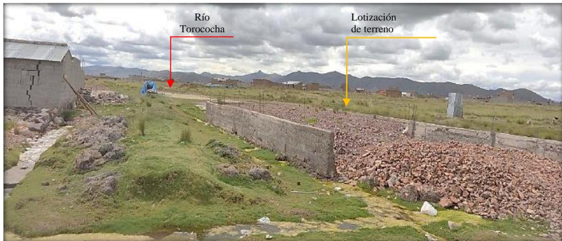
**Figura 64.** Vista de la interrupción del río Torococha con la lotización de terreno en pleno cauce, de esta forma es interrumpido el flujo natural existente. N: 8286423 – E: 374612.
