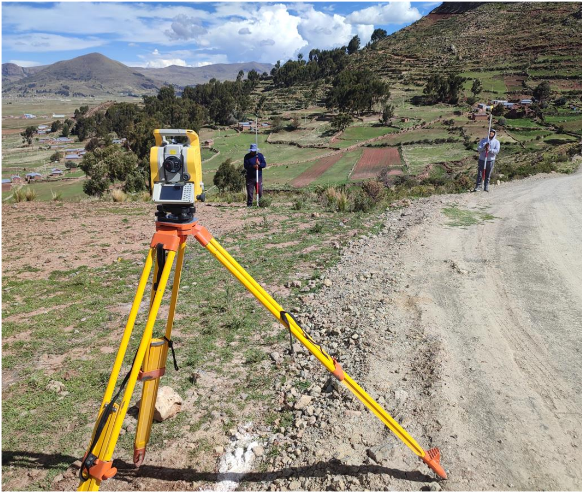
Figura 15: Levantamiento Topográfico con Estación Total Vista con Prisma.
