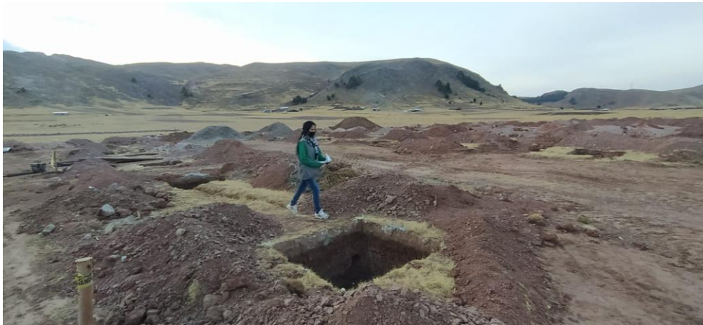
Figura 15. Construcción de CA
