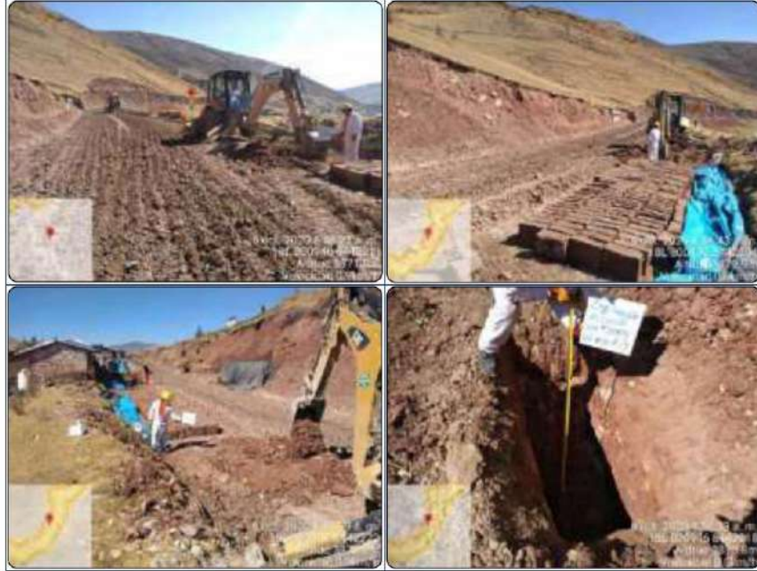
UBICACIÓN: Km. 53+100 CALICATA: C-09 LADO: Derecho PROFUNDIDAD: 0.00 - 1.50 mts.
