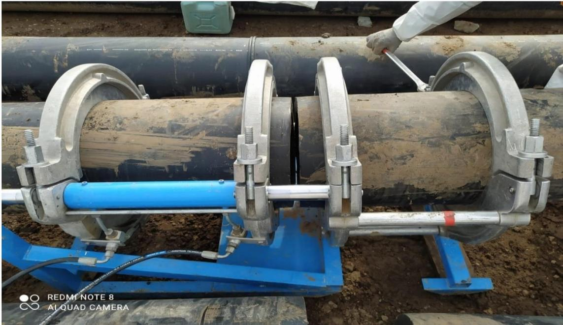
Foto 3. Posicionamiento y alineamiento de la tubería HDPE
