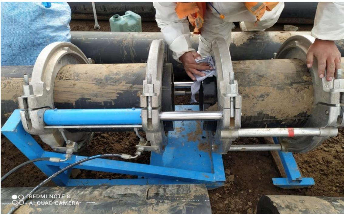
Foto 2. Limpieza de la tubería HDPE
