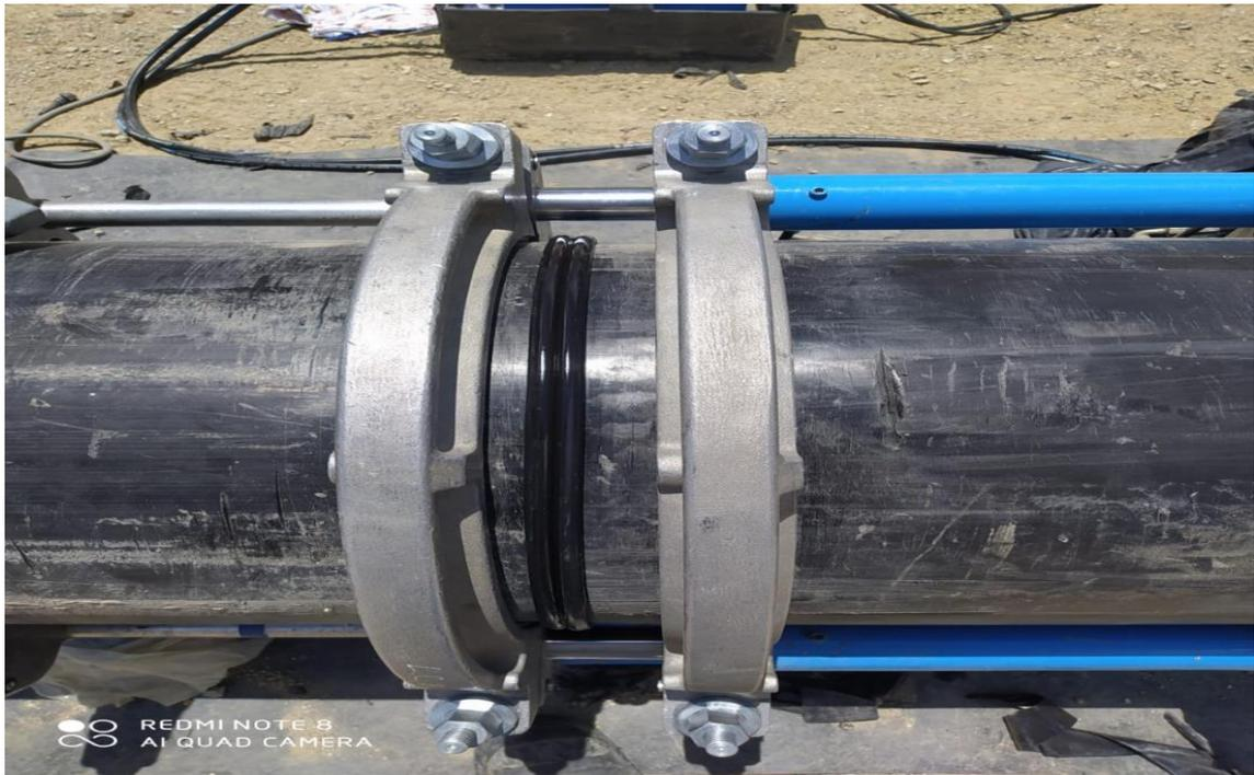
Foto 5. Producto final de la termofusión en tuberías HDPE
