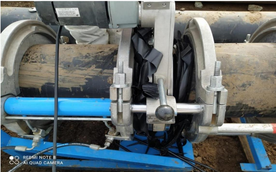
Foto 4. Refrentado de la tubería HDPE
