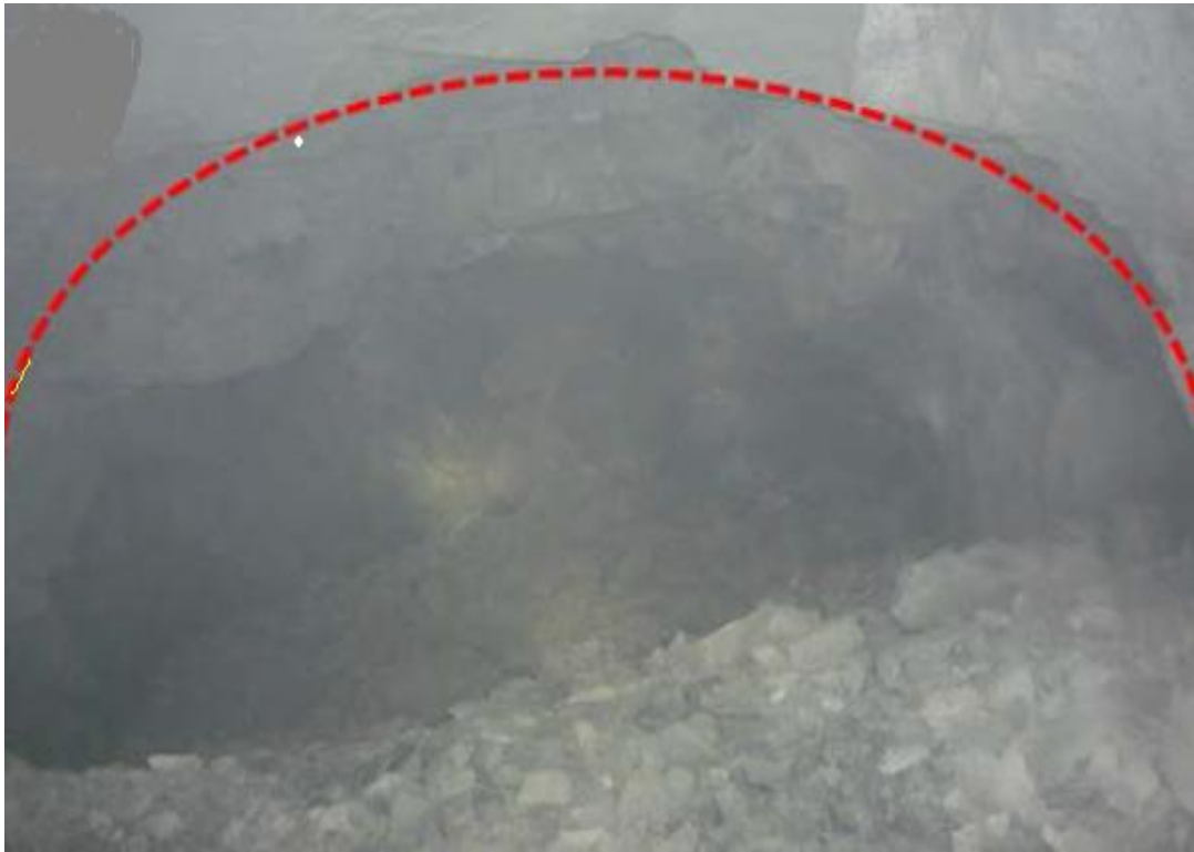
Foto 01. Sección después de la voladura.
