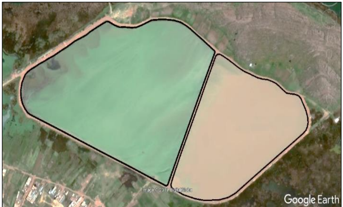
Figura 5. Lagunas de estabilización El Espinar, Puno – Perú.
