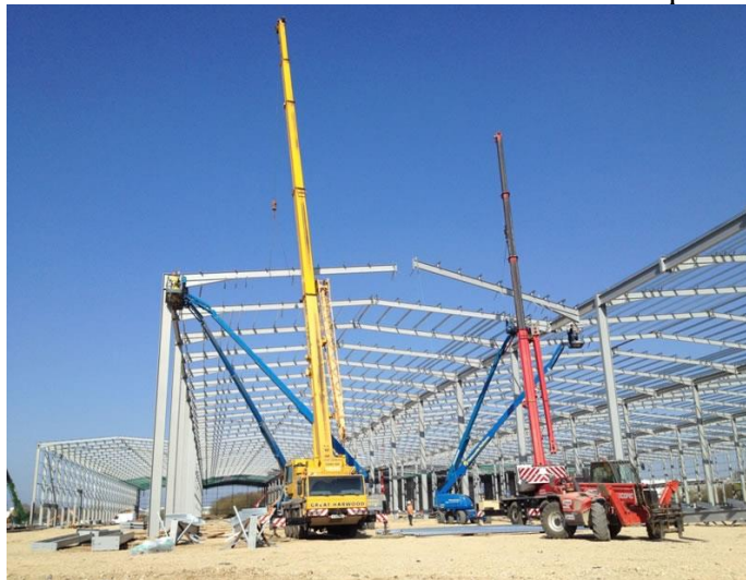
Figura 19: Elaboración de estructuras metálicas con maquinaria
