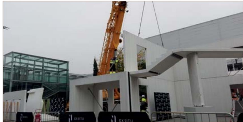
Figura 13: Colocación mediante maquinaria de Hormigón Prefabricado
