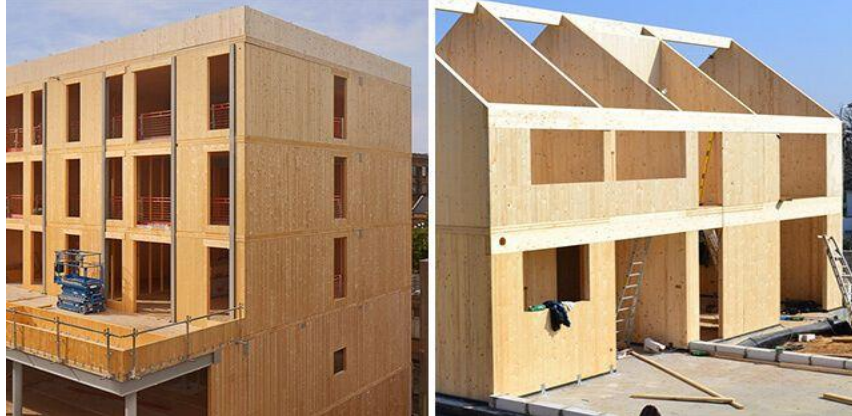
Figura 18: Construcción con paneles de madera contraplacada
