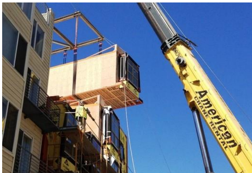
Figura 10: Ubicación de módulos con maquinaria.
