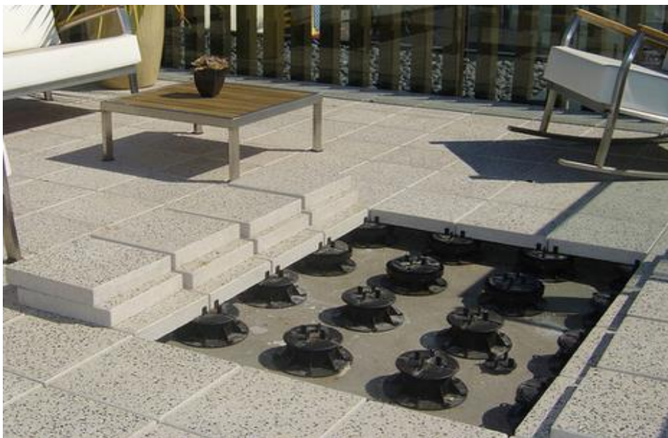
Figura 174: Panel piso pastelones de concreto.
