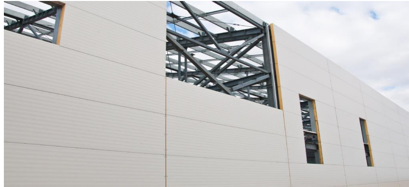
Figura 11: Ubicación de paneles constructivos alrededor de módulo.
