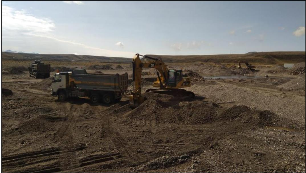
**Figura 12.** Se observa el acopio y transporte de material granular del río Macusani
