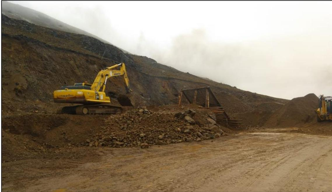
**Figura 11.** Se observa el zarandeo de material granular de cantera en la prog. 23+500.
