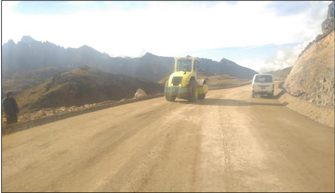
**Figura 16.** Se observa el compactado de la estructura de pavimento a nivel de la sub base granular en las progresivas km. 23+010 - 23+560.
