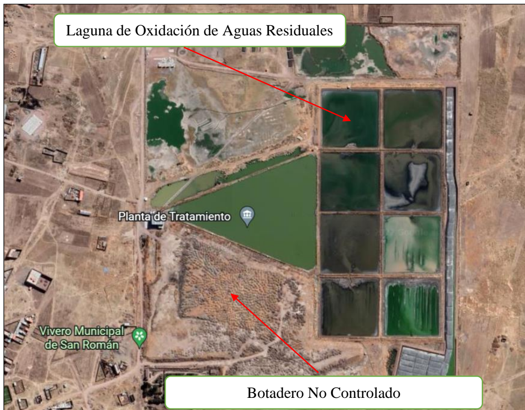
Figura 4: Vista Satelital del Botadero de Chilla
