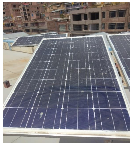
Figura 3.2: Utilizado como un generador FV, panel solar de 270W
