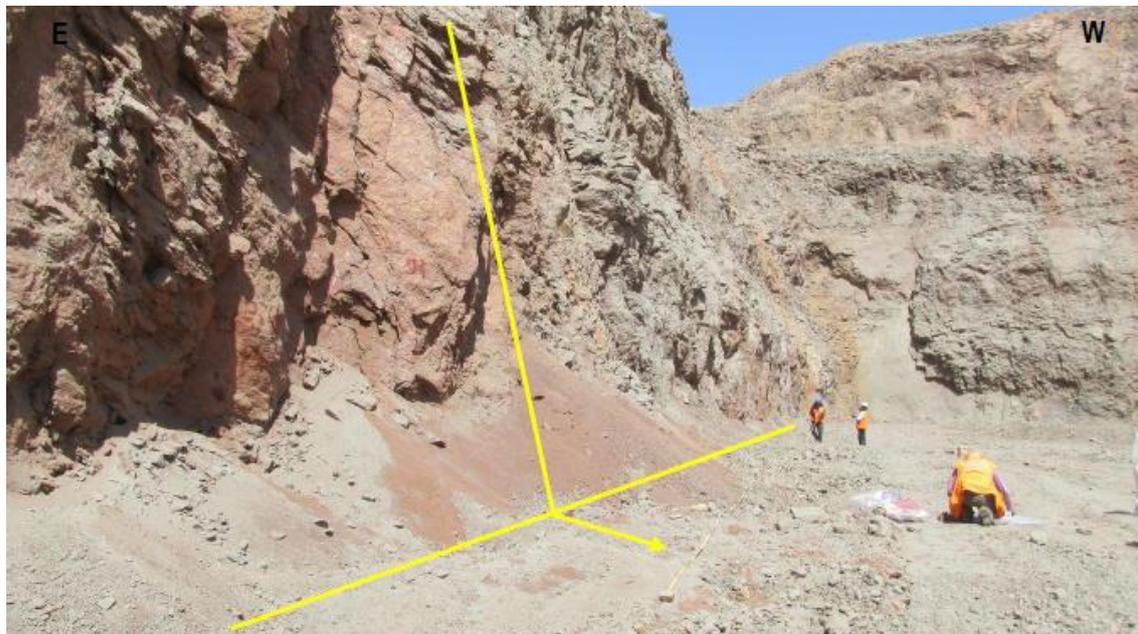
**Figura 47.** Vista de la EG-30, Nivel 641 donde se realizó la línea de detalle de 50 m de longitud. Con dirección de buzamiento del talud: 350° y buzamiento de talud: 66°.
