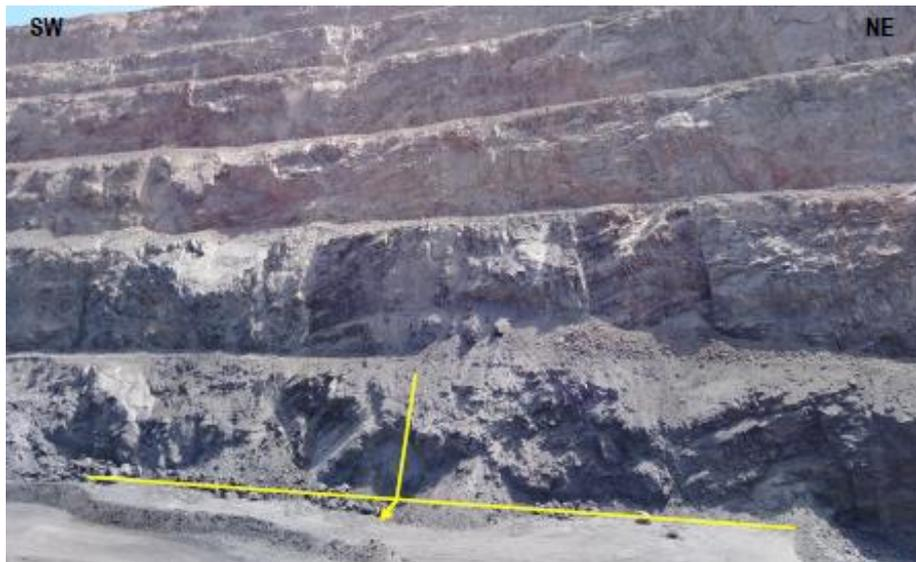
**Figura 46.** Vista de la EG-03', Nivel 545 donde se realizó la línea de detalle de 140 m de longitud. Con dirección de buzamiento del talud: 159° y buzamiento de talud: 72°.
