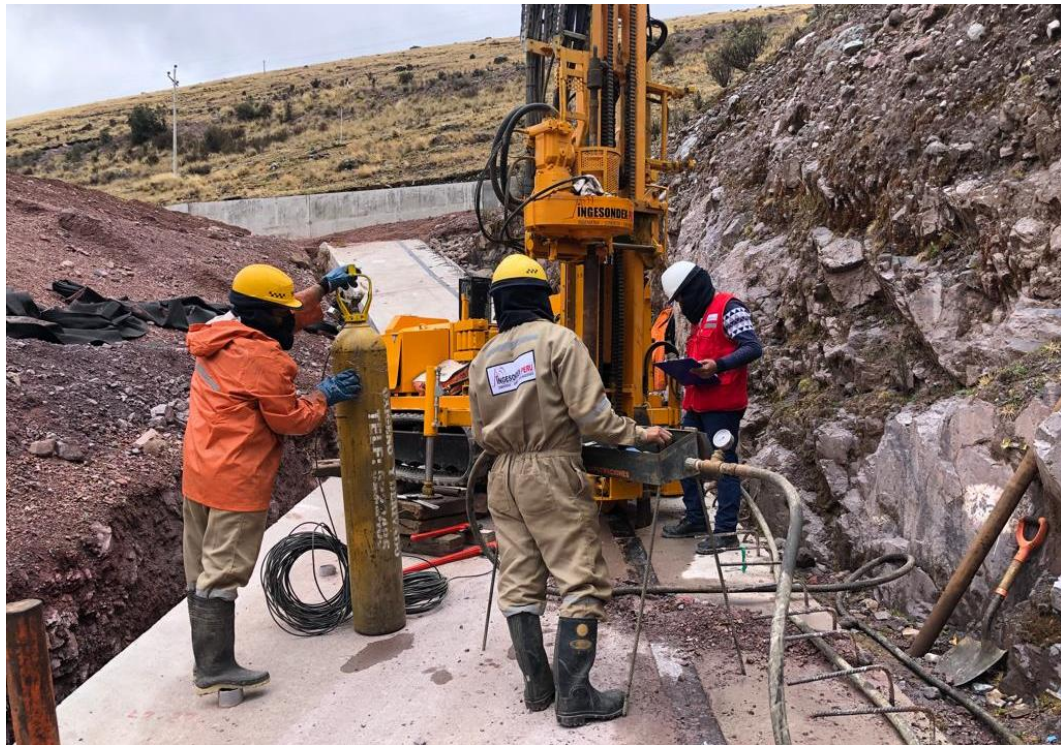
Figura 37. Ejecución del ensayo Lugeon.
