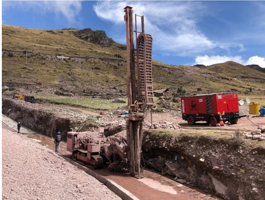
Figura 19. Perforaciones rotopercusivas en plinto de la represa.
