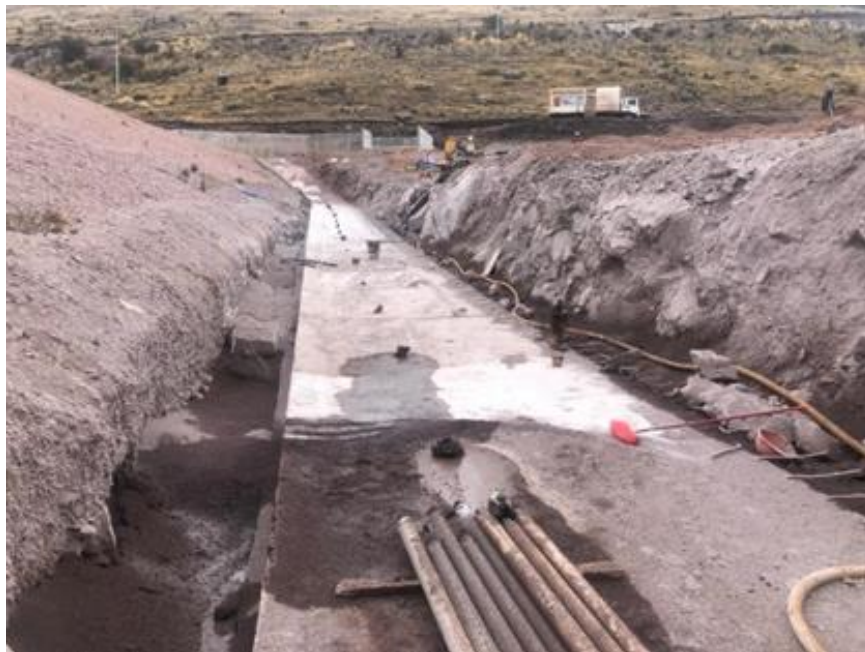
Figura 34. flujo de agua por debajo del cuerpo de la presa.
