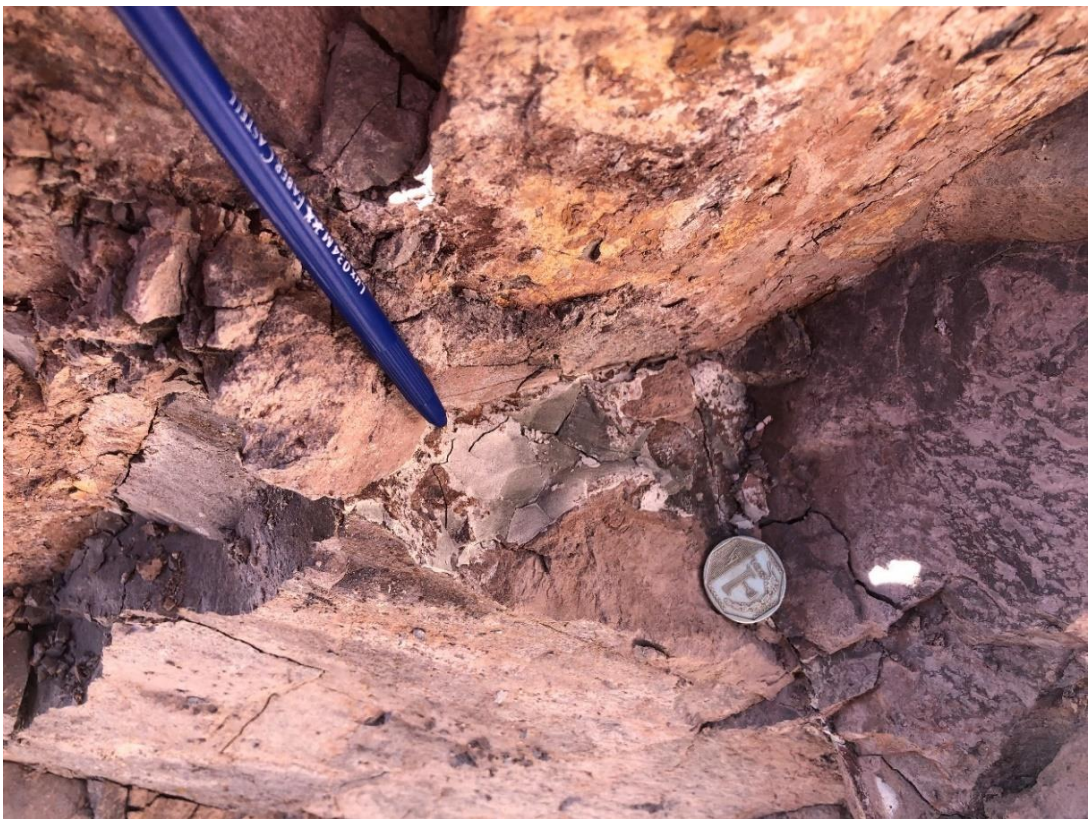
Figura 59. Evidencia de mezcla inyectada en campaña 2021.
