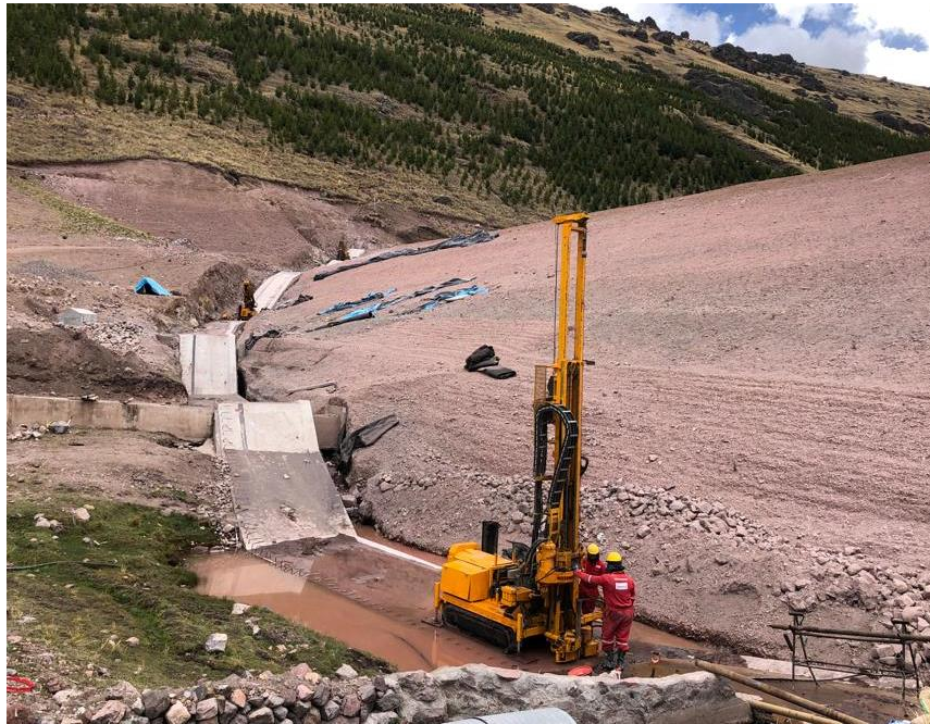
Figura 18. Perforaciones diamantinas en plinto de la represa.
