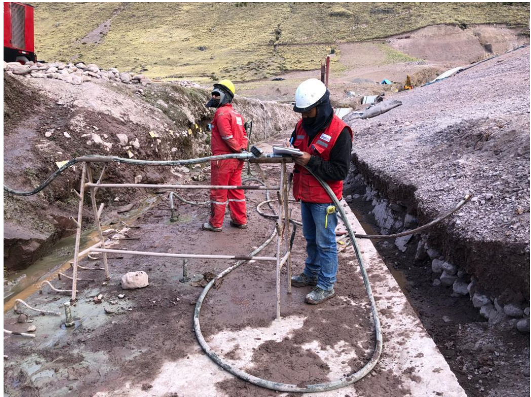
Figura 36. Ejecución del ensayo Lefranc.
