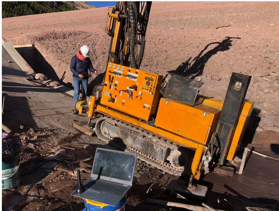
Figura 23. control del nivel de agua en los pozos perforados.
