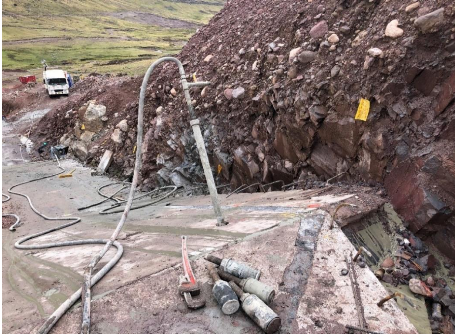
Figura 51. Trabajos de inyección de lechada.
