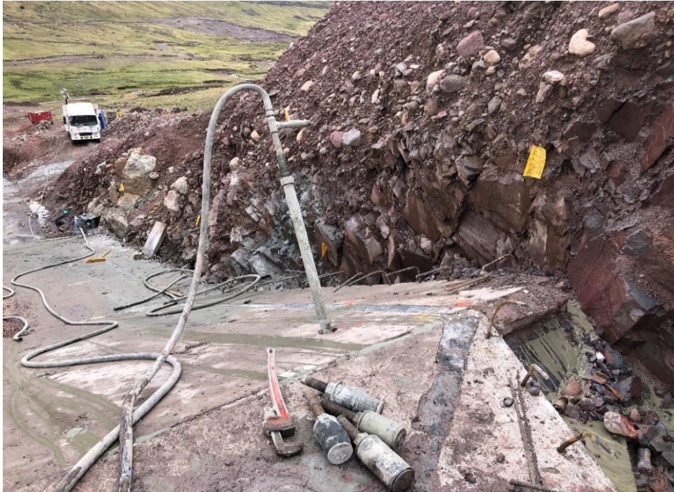
Figura 27. Trabajos de inyección de lechada.
