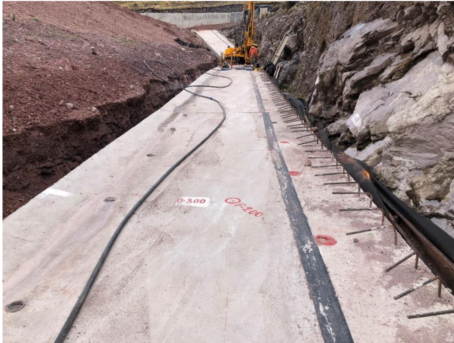
Figura 17. Marcado y distribución de los pozos de perforación.
