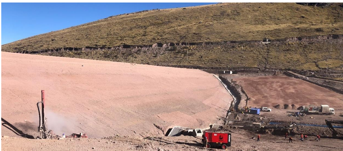
Figura 33. Depósitos antropogénicos, vista al cuerpo de presa y blanquet.
