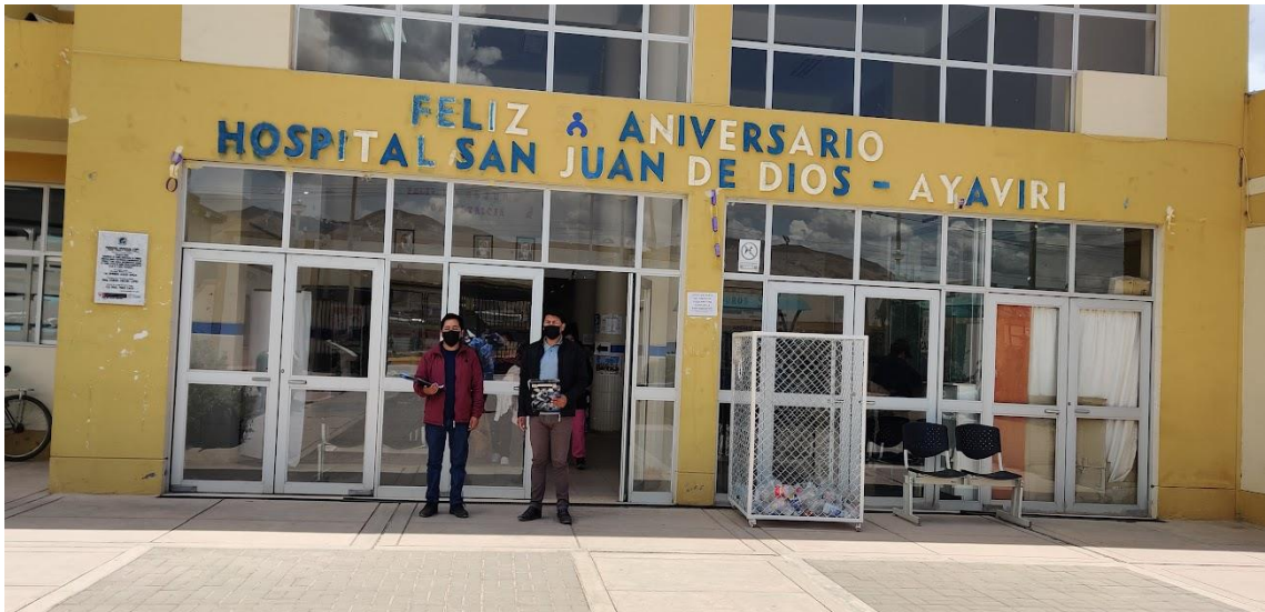
Imagen N° 03: Puerta principal de acceso al Hospital San Juan de Dios-Ayaviri.
