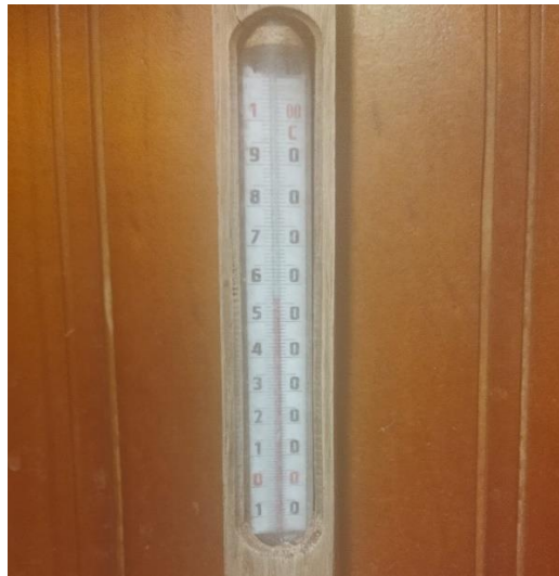
Figura 21: Termómetro analógico instalado dentro de la cámara seca
