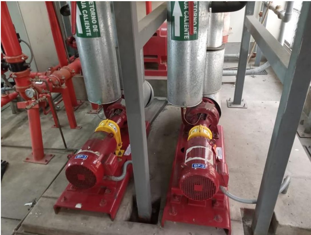
Figura 10: Sistema primario de bombas.
