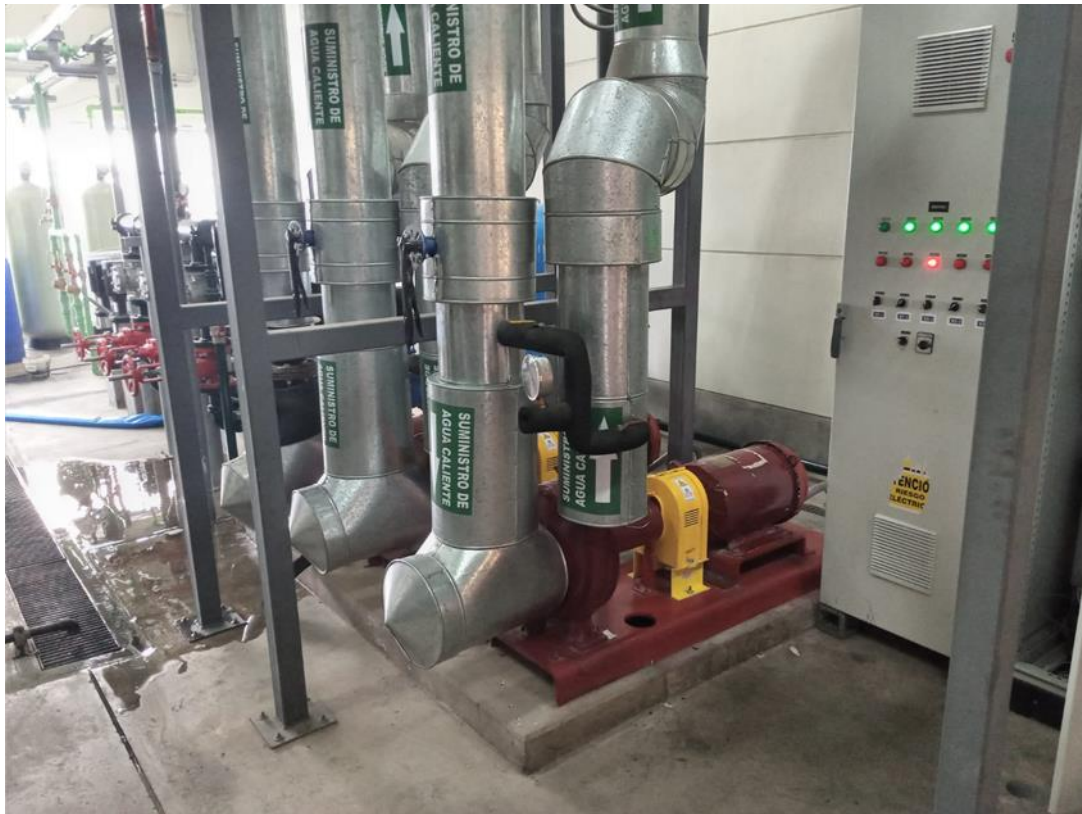
Figura 11: Sistema secundario de bombas.
