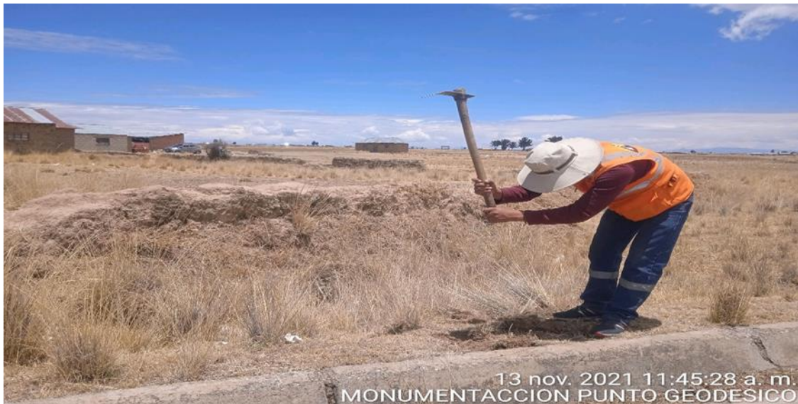
Figura 25. Excavación para la monumetanción de puntos Geodésicos
