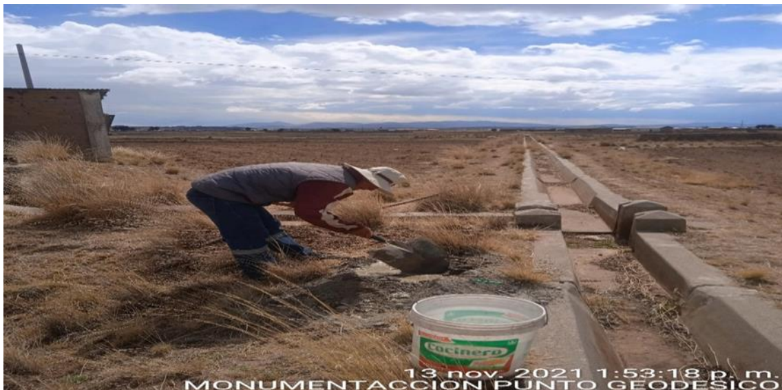
Figura 26. Preparado de concreto para el vaciado de los puntos Geodésico
