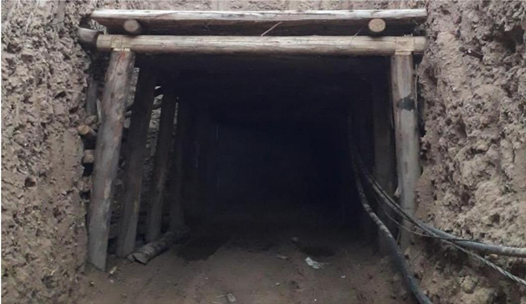
**Figura 22.** Sostenimiento con cuadros de madera en un fallo
