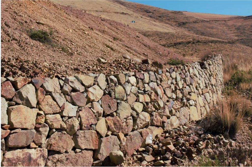
**Figura 18.** Zona de contención de desmonte
