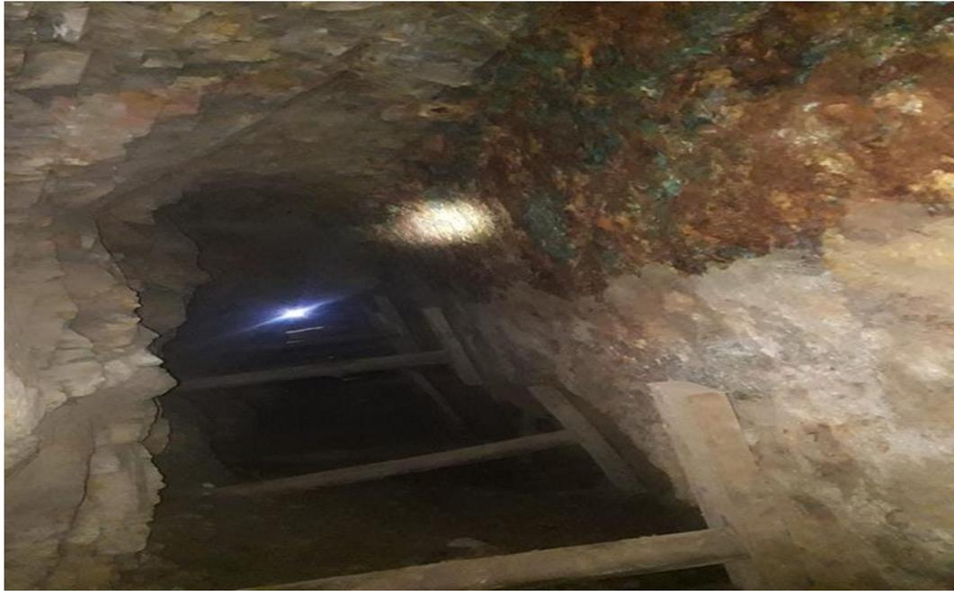
**Figura 24.** Sostenimiento en un punto de tajeo con puntales y plantillas de madera
