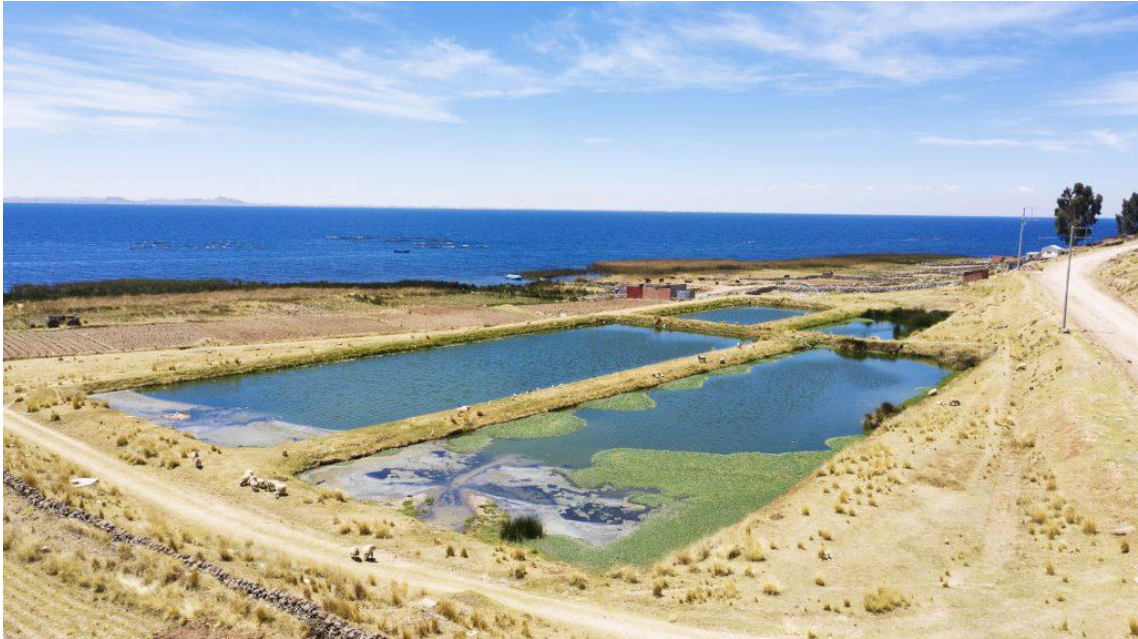
Figura 27. Situación actual de la laguna de oxidación en Juli
