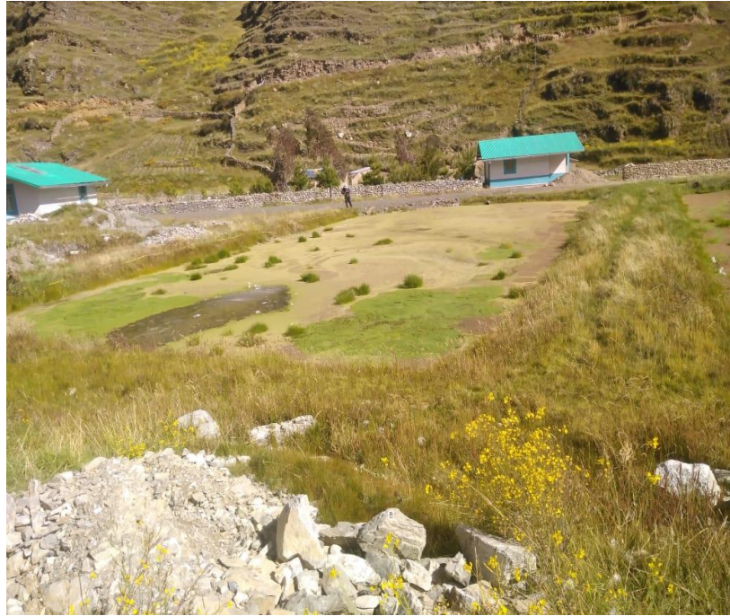
Figura 10. Presencia de viviendas a inmediaciones de las lagunas de oxidación
