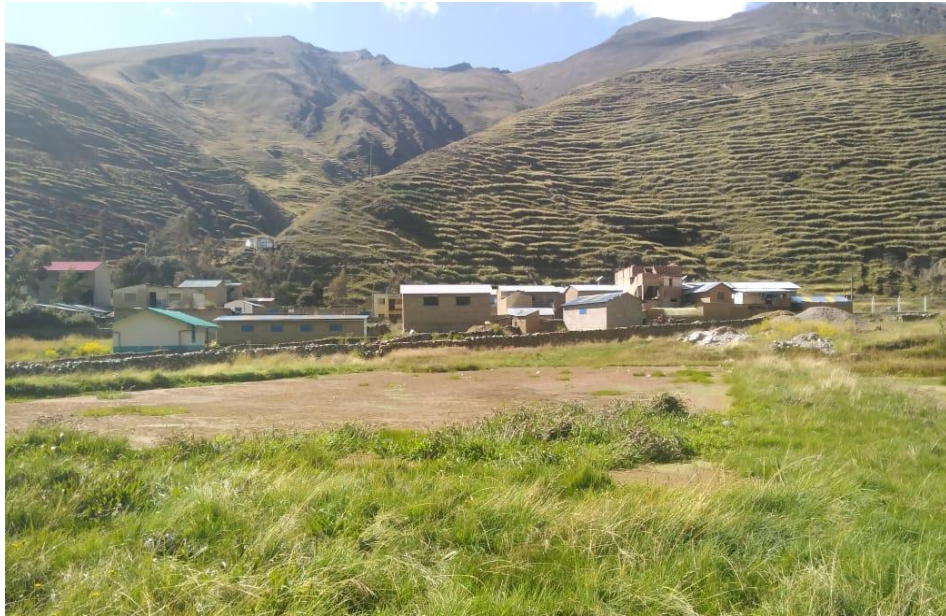
Figura 16. Ubicación de las lagunas de oxidación
