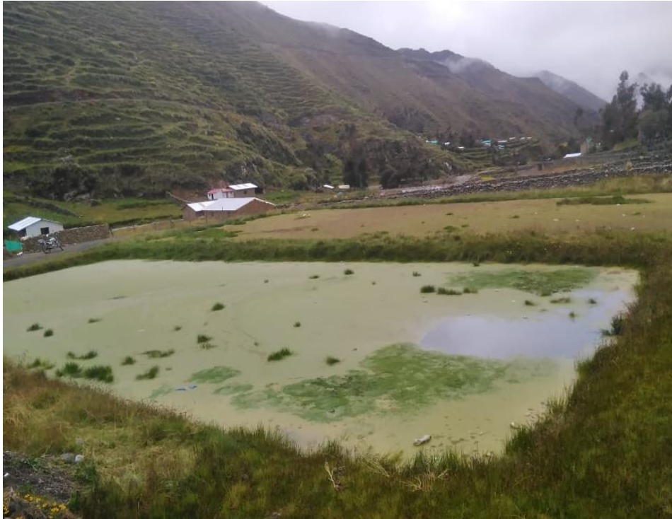
Figura 20. Ausencia de cerco de protección en la laguna de oxidación
