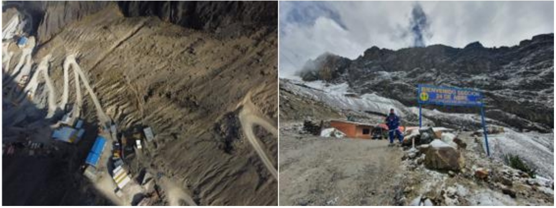
Figura 14: Las instalaciones del campamento minero 24 de Abril.
