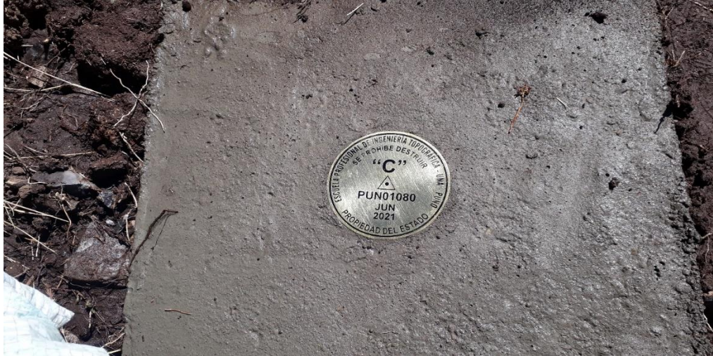
Figura 13. Monumentación del punto PU01080
