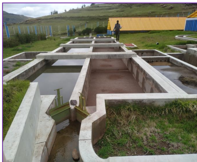
Filtro de arena Capachica
