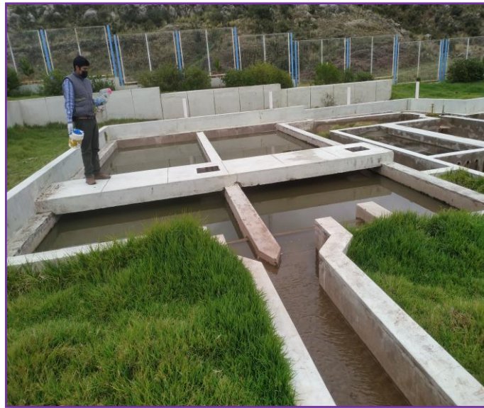
Filtro de arena Capachica
