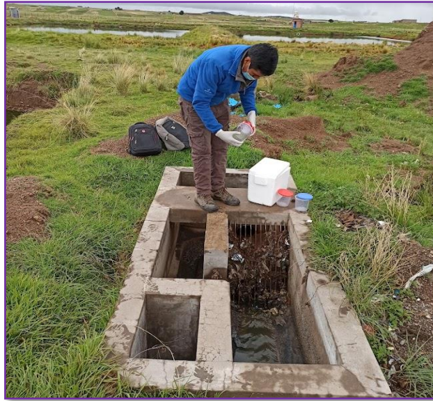
Cámara de rejas PTAR Cabana
