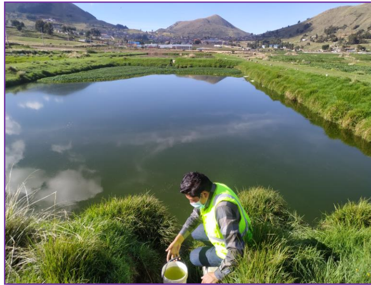
Lagunas de facultativas secundarias PTAR Juli
