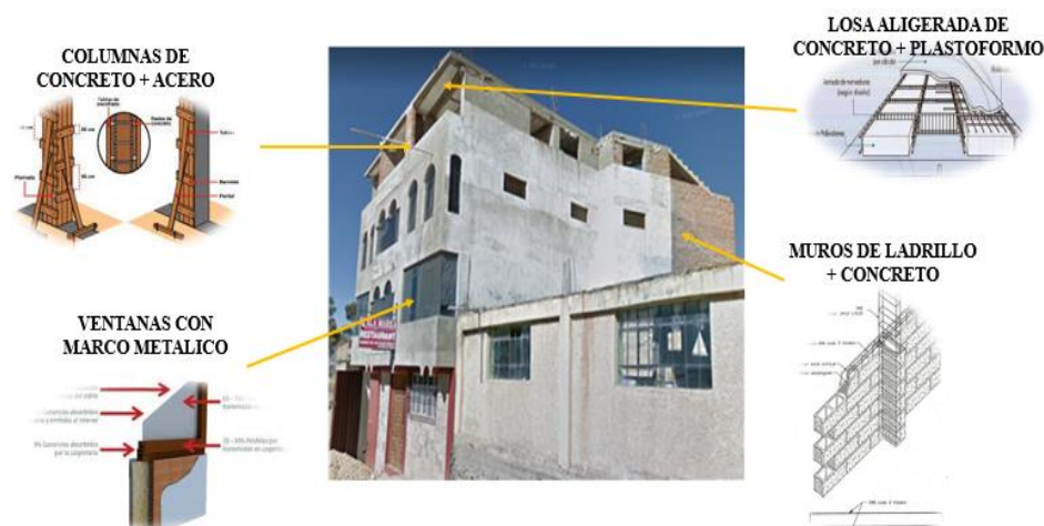
Figura 45: Sistema Constructivo de Viviendas de Material Noble
