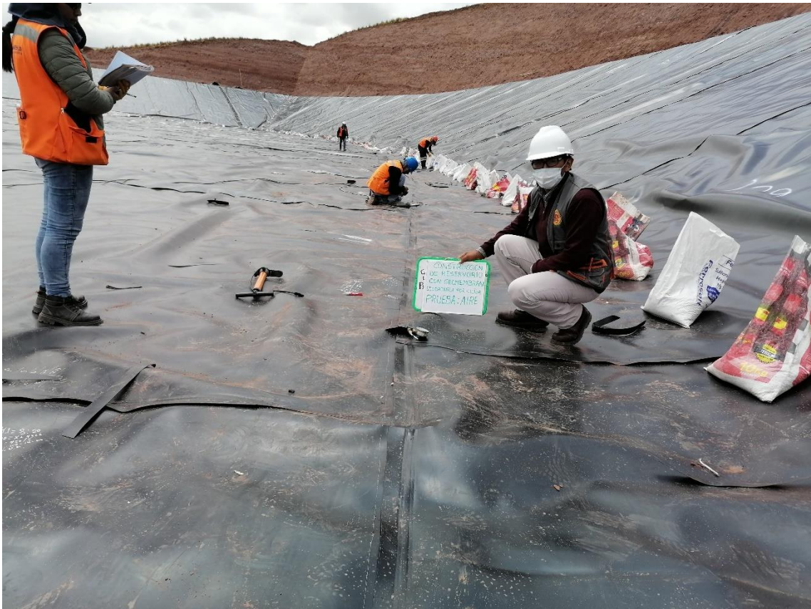
Figura 8. Toma de muestra para los ensayos no destructivos prueba de aire.
