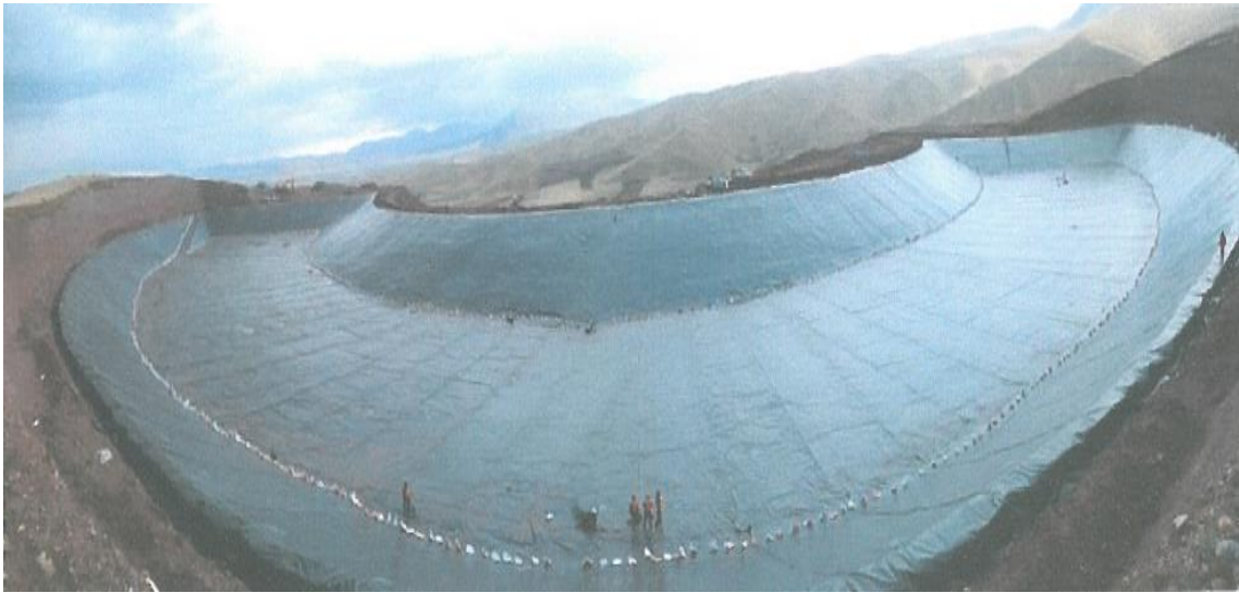
Figura 4. Vista general del reservorio con instalación de la geomembrana.
