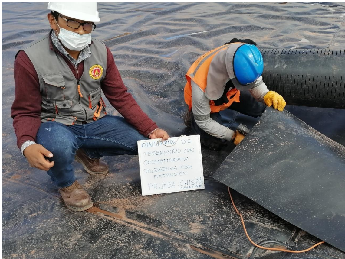
Figura 10. Toma de muestra para los ensayos no destructivos chispa eléctrica.
