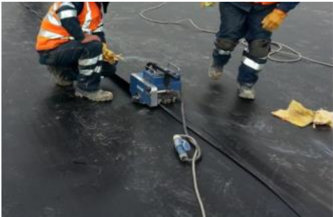
Figura 5. Se observa la soldadura por fusión de la geomembran.
