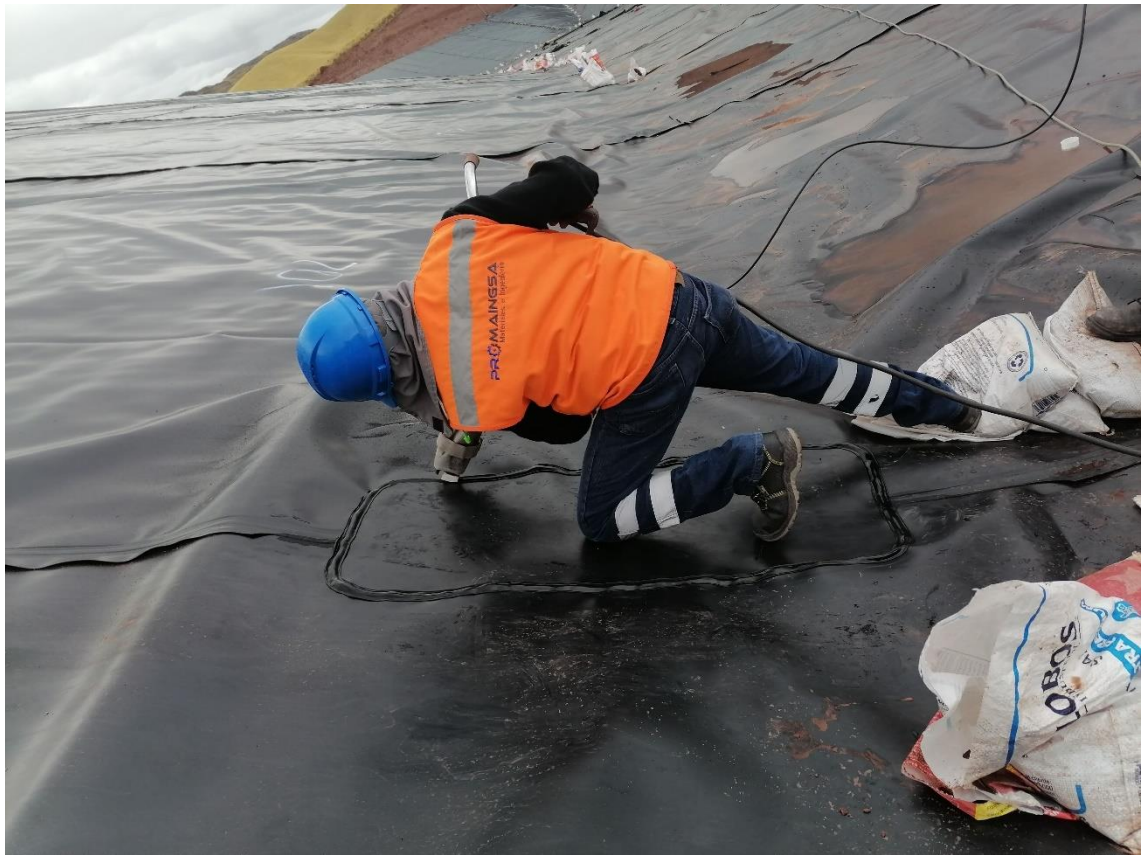
Figura 6. Se observa la soldadura por extrusión de la geomembrana.
