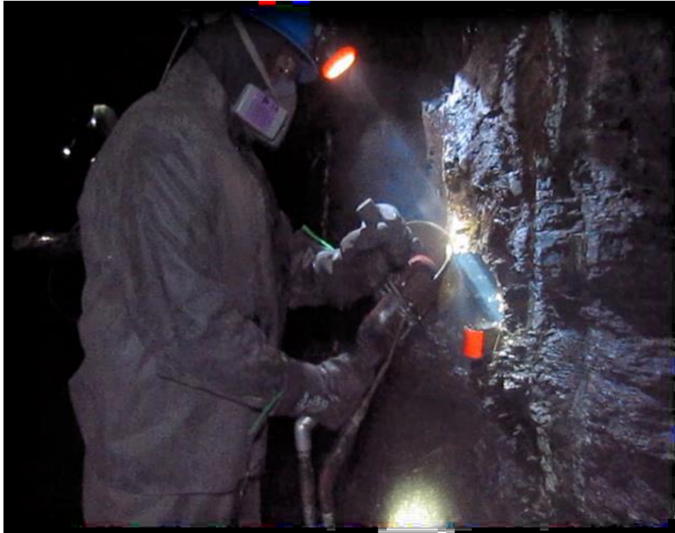
Figura 11. Muestreo de hastiales en la Galería 7790N
