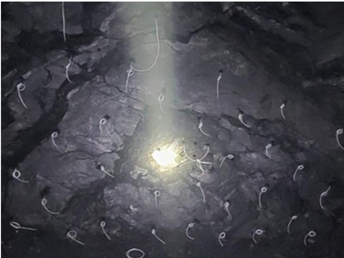
Figura 6. La malla de perforación de la guardia "C"
