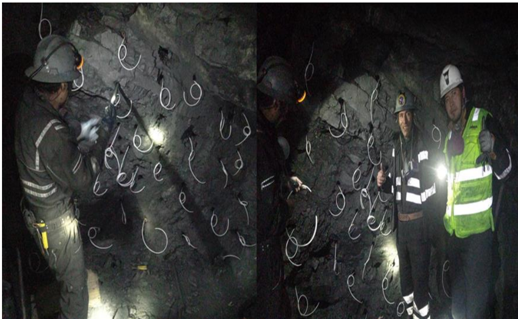
Figura 7. La malla de perforación para realizar la prueba con emulnor 3000
