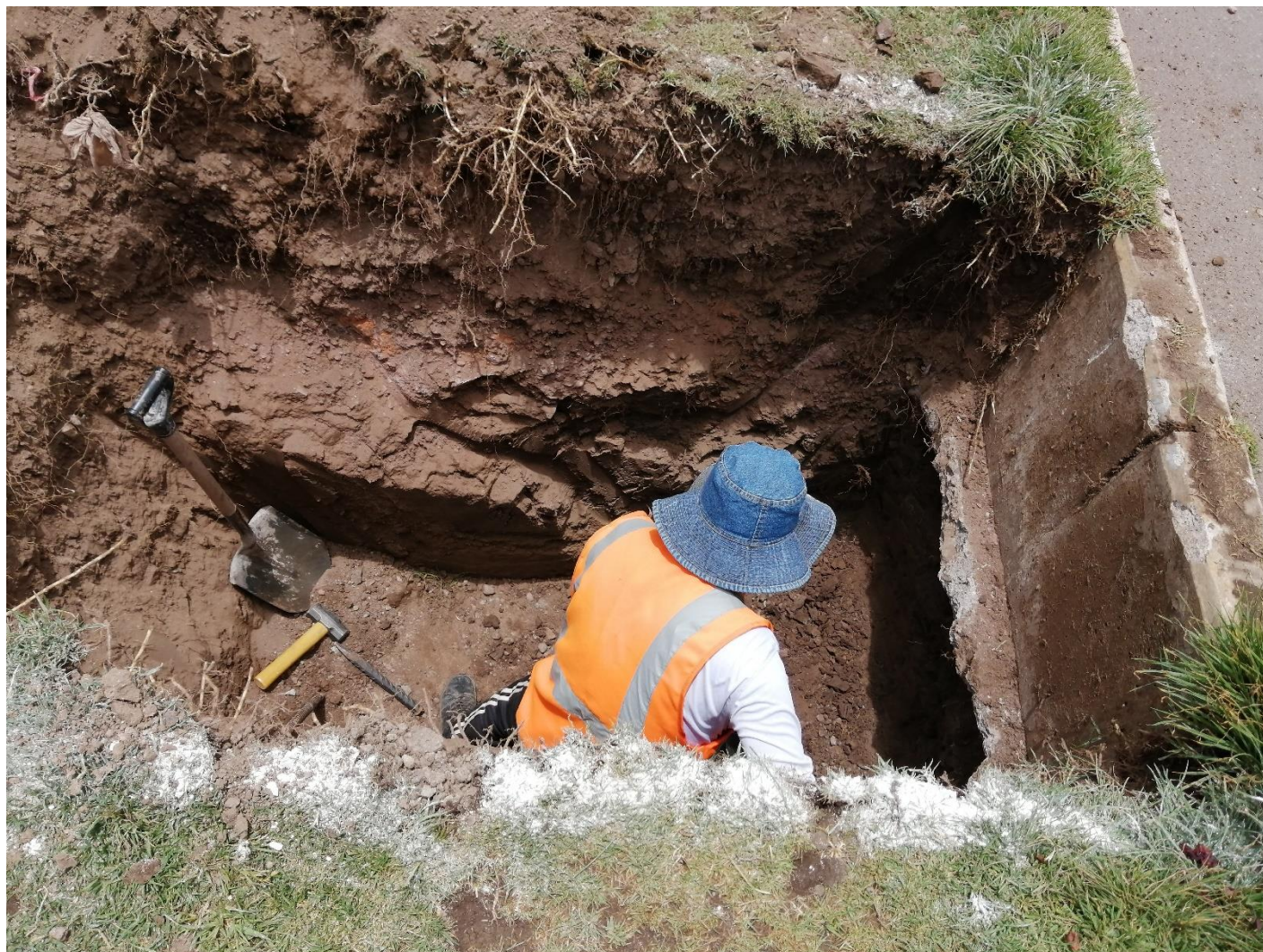
FOTOGRAFÍA E -1: A continuación, se muestra el proceso de exploración de suelo, llegando a excavar hasta una profundidad de 1.50m por debajo de la carpeta asfáltica.
