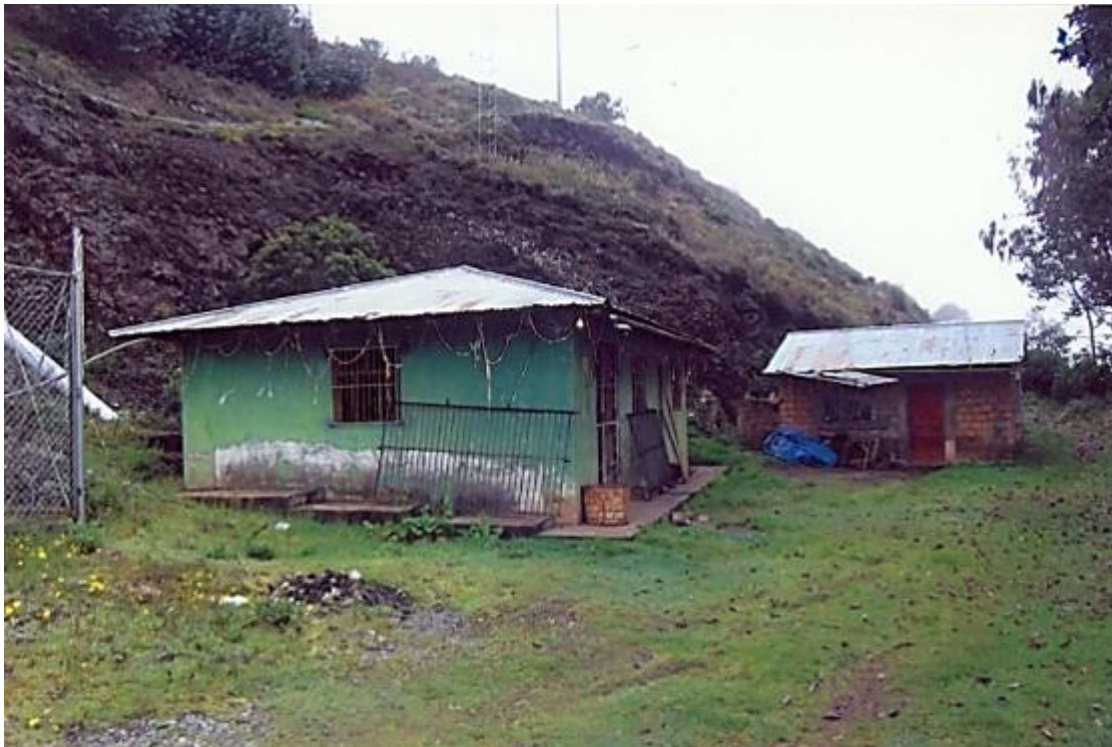
Figura 91. Casa de máquinas (pintada de verde). A su izquierda ingresa la tubería de presión, a la derecha se aprecia la vivienda del operador.
