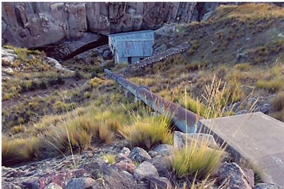
Figura 78. Tubería de presión (20" \varnothing ) y casas de máquinas antigua (la de arriba) y la actual (la inferior, la más cercana al río). Fuente: Leonel Castillo (2018).
