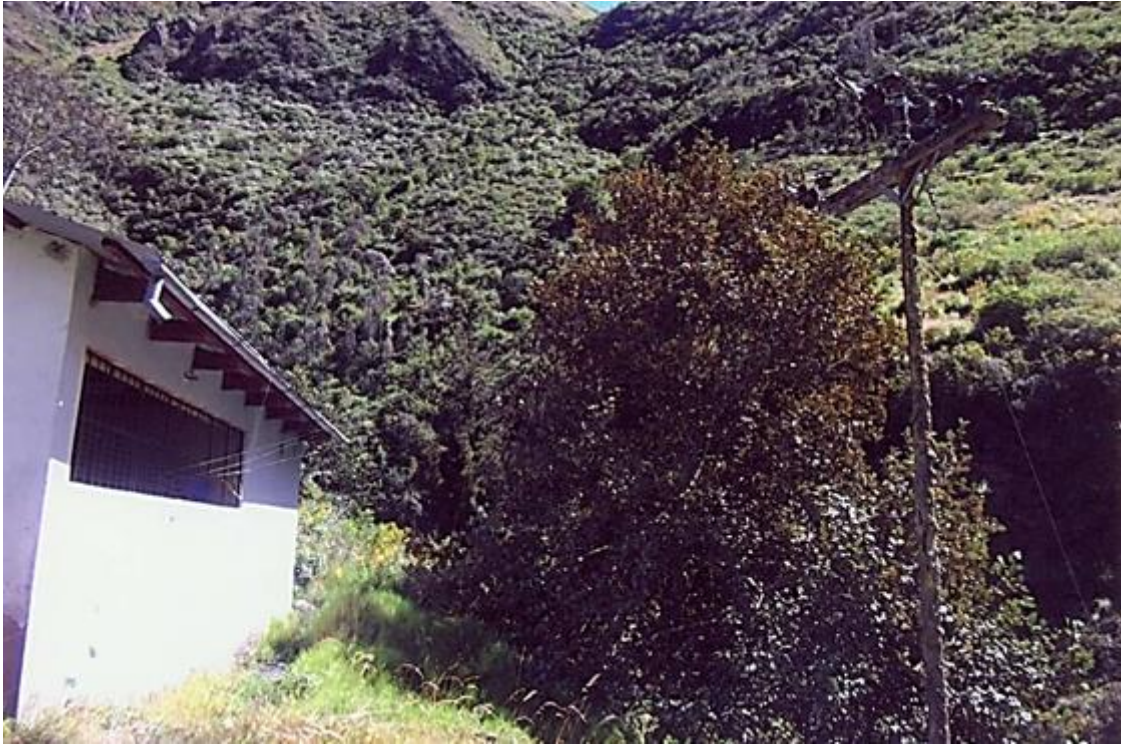
Figura 39. Casa de máquinas y poste de arranque de la línea de media tensión (22900 voltios).
