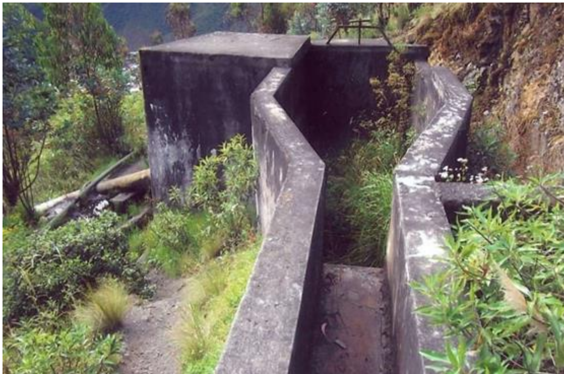
Figura 34. Nuevo desarenador y su cámara de carga.
