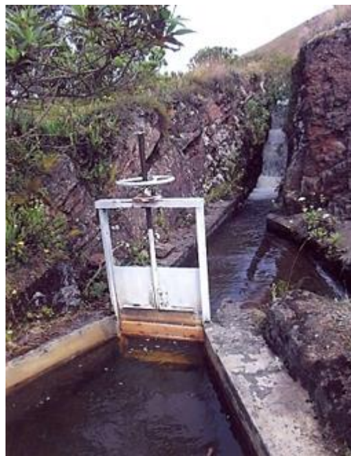
Figura 86. Llegada del agua al desarenador y cámara de carga Fuente: Leonel Castillo (2018).
