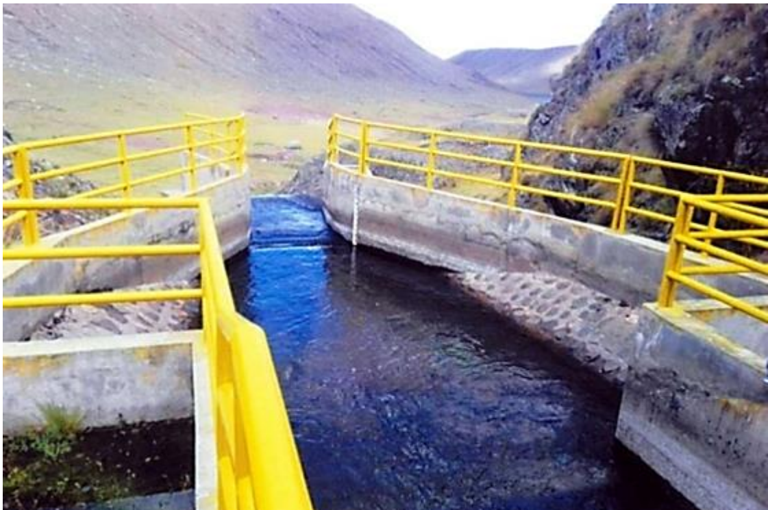
Figura 74. Compuerta de regulación en la última laguna para derivar el agua hacia Tocca y hacia San Gabán II. Fuente: Leonel Castillo (2018).
