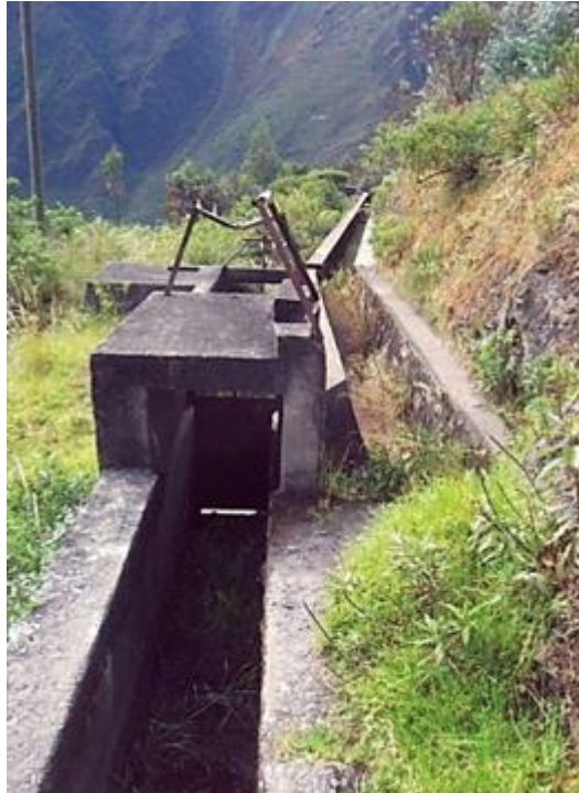
Figura 33. A partir del desarenador de la minicentral Ollachea I, se agregó un tramo nuevo, adicional, a fin de lograr una mayor altura bruta de caída para la nueva minicentral.
