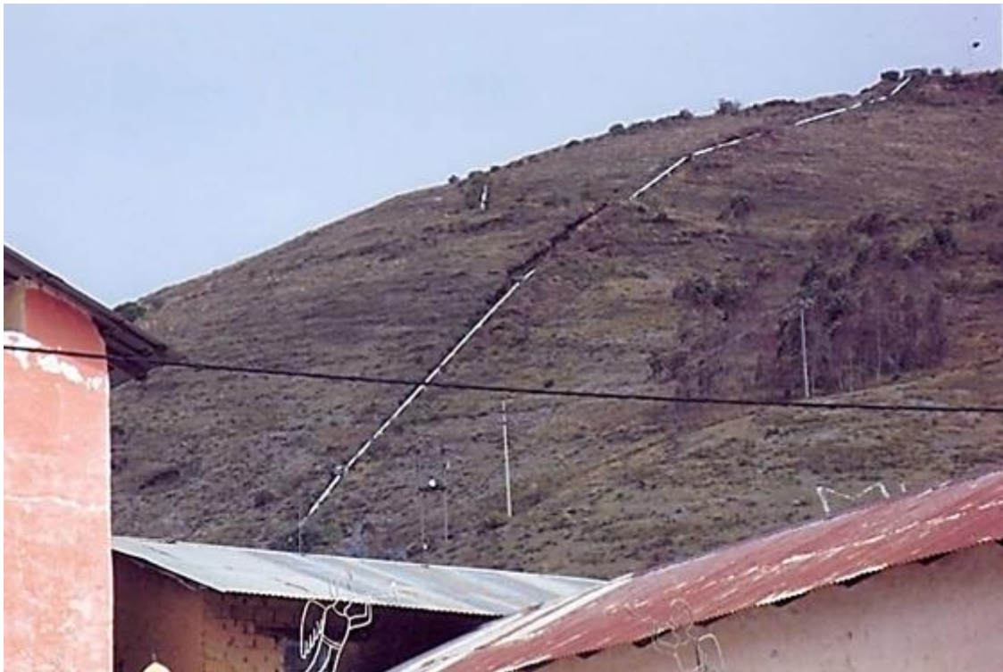
Figura 89. Vista panorámica de la extensa tubería de presión instalada en las faldas del cerro, aproximadamente 190 metros de longitud. Fuente: Leonel Castillo (2018).
