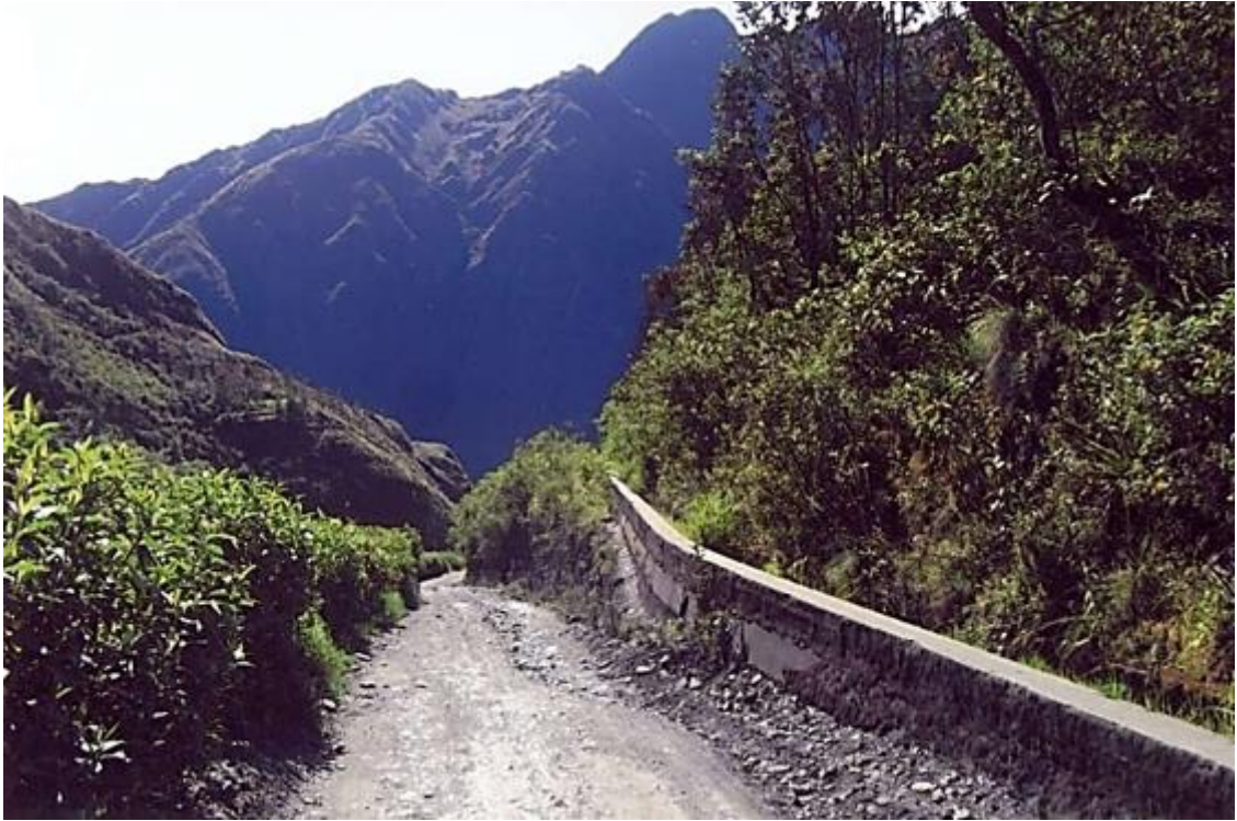
Figura 17. Panorámica parcial del trayecto del canal, al costado derecho de la carretera. Fuente: Leonel Castillo (2018).
