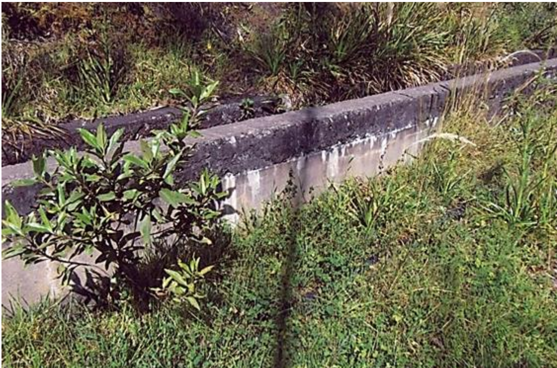
Figura 32. Se aumentó la capacidad de conducción del canal que ya existía en 40%, elevando la altura de sus paredes laterales. Fuente: Leonel Castillo (2018).
