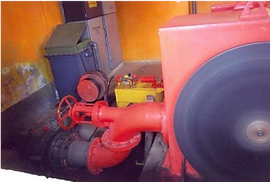
Figura 93. El único inyector de la turbina Pelton de 100 kW. Fuente: Leonel Castillo (2018).
