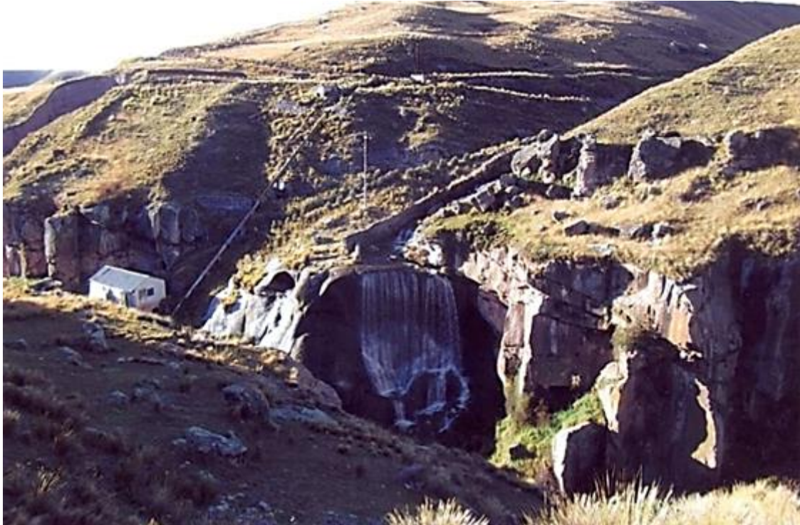
Figura 77. Vista panorámica de la minicentral hidroeléctrica Tocca, ubicada en el cañón del mismo nombre y en la margen derecha del río Macusani. Fuente: Leonel Castillo (2018).
