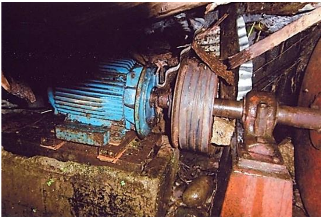
Figura 66. El generador trifásico (75 kW – 400 V) también en proceso de deterioro. Fuente: Leonel Castillo (2018).
