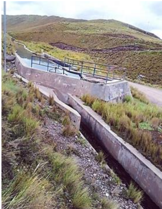
Figura 75. Parte final del canal de concreto que conduce el agua hacia la minicentral Tocca. También se ve el desarenador. Fuente: Leonel Castillo (2018).
