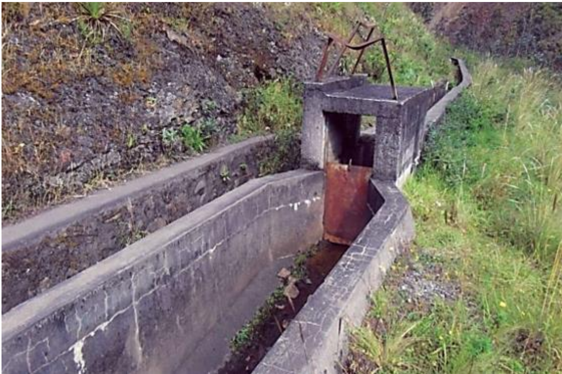
Figura 19. Llegada del canal hasta la compuerta de regulación e ingreso al desarenador. Fuente: Leonel Castillo (2018).
