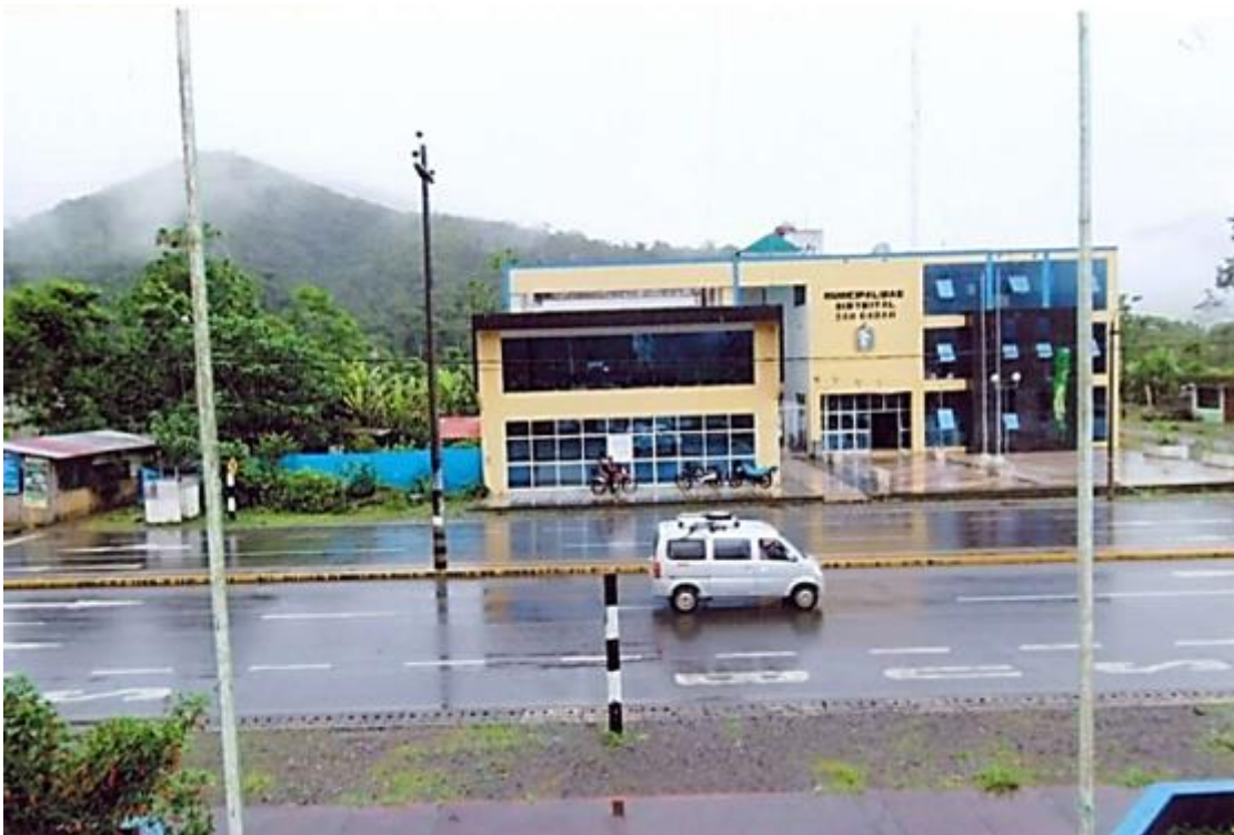
Figura 51. Local nuevo del Municipio Distrital de San Gabán (año 2015). Nótese la amplitud y modernidad. Fuente: Leonel Castillo (2019).
