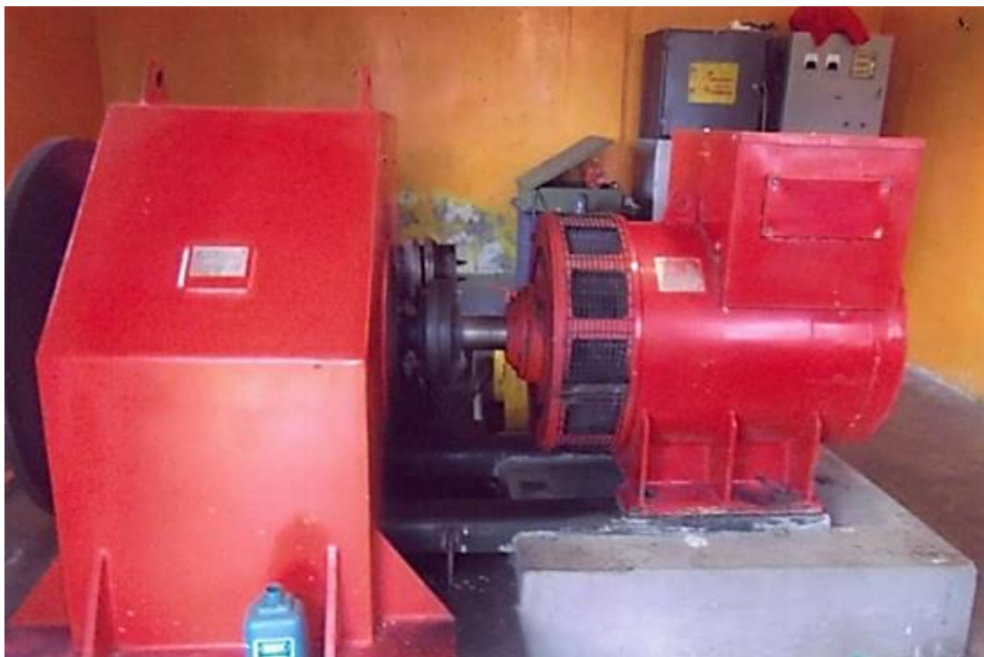
Figura 92. Turbina Pelton (izquierda), marca SATUR, accionando al generador de 100 kW (derecha).
