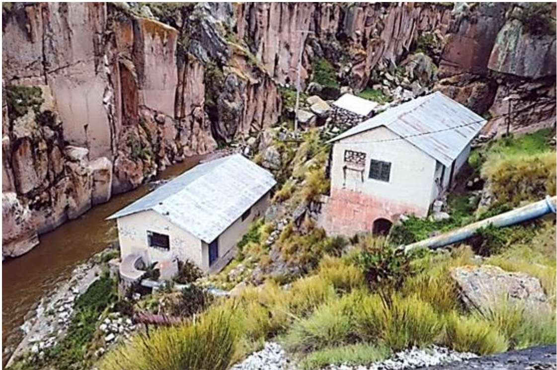
Figura 79. Vista detallada de las dos casas de máquinas, emplazadas dentro del pintoresco cañón de Tocca. La izquierda es la actualmente operativa, la otra ya fue desmantelada. Fuente: Leonel Castillo (2018).
