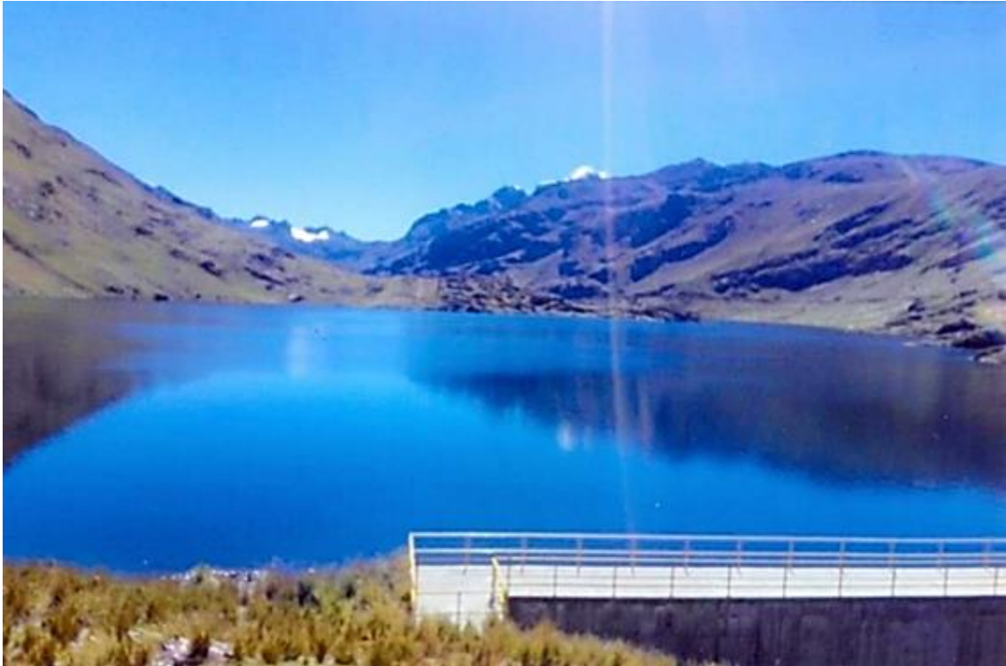
Figura 73. La más cercana de las tres lagunas que se usan como reservorio de las aguas provenientes del nevado Chichi Kapac. Esas aguas se usaban para la minicentral de Tocca (Macusani) y más abajo se usan en la gran central San Gabán II. Fuente: Leonel Castillo (2018).
