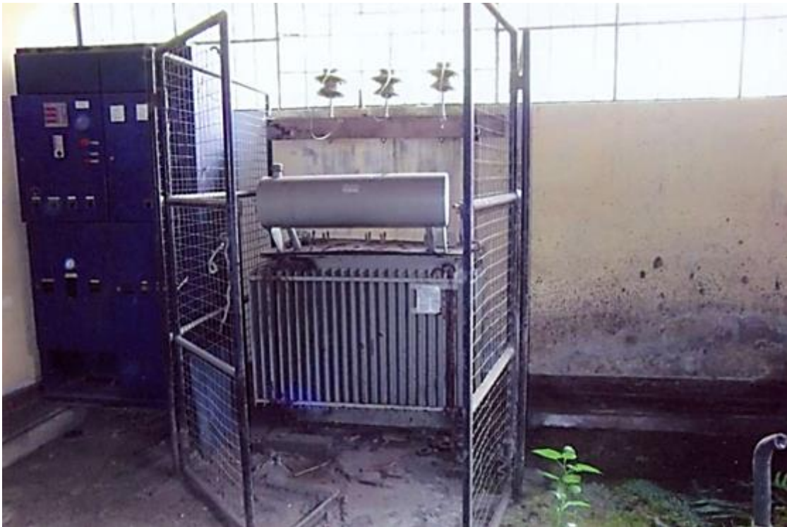
Figura 47. Tablero de control y transformador trifásico ELKO de 250 kVA, 400/22900 V Fuente: Leonel Castillo (2019).
