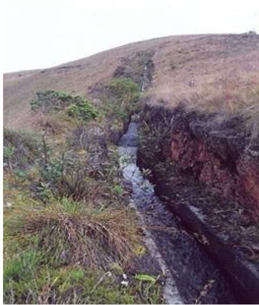
Figura 85. En su parte final, dicho canal ya está revestido de concreto Fuente: Leonel Castillo (2018).
