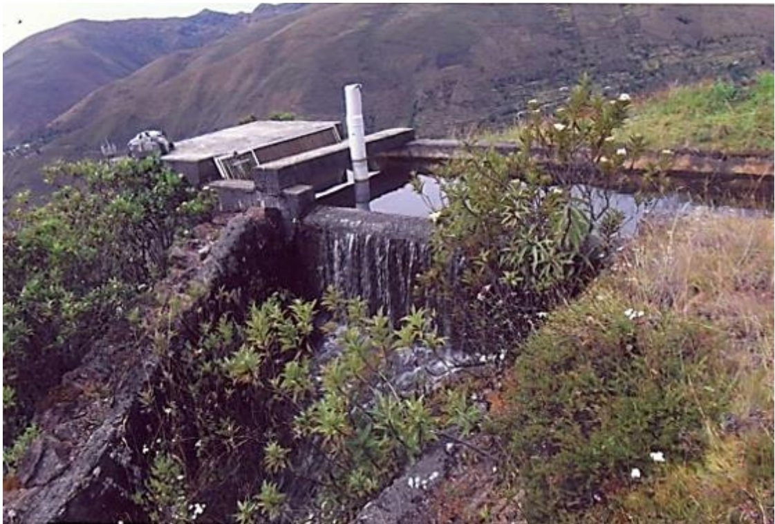
Figura 87. Aliviadero, rebose de las aguas sobrantes Fuente: Leonel Castillo(2018).
