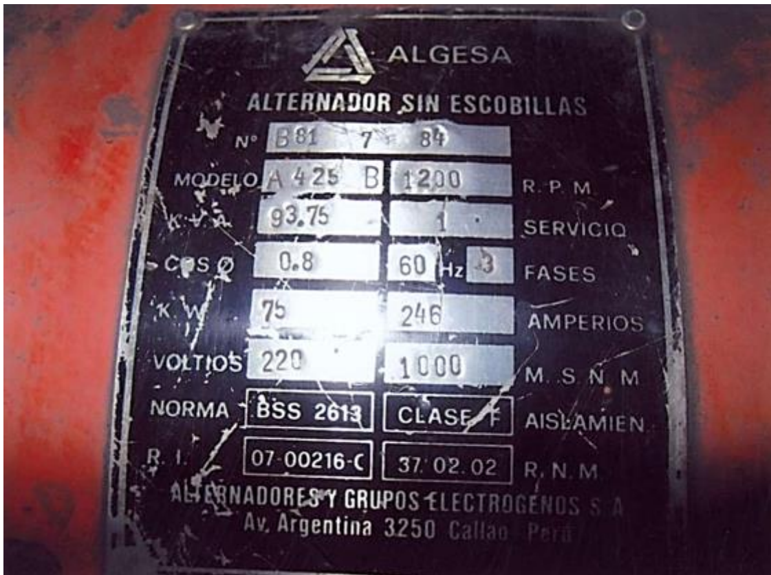
Figura 29. Placa del generador ALGESA (Callao – Perú), de 75 kW. Fuente: Leonel Castillo (2018).
