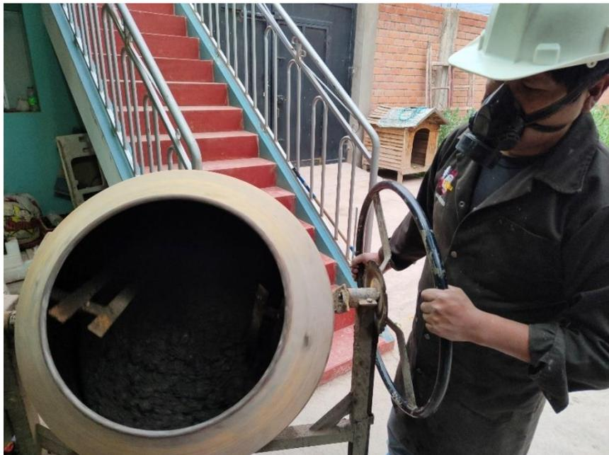
*Figura 6 “Preparación de la mezcla”*
