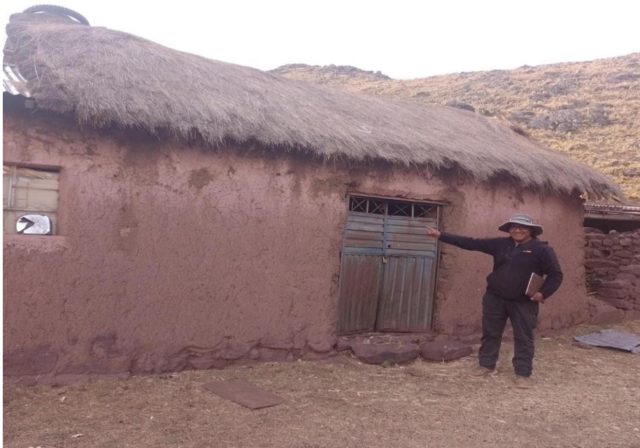
Figura 81. Vivienda construida con pared de adobe y techo de paja
