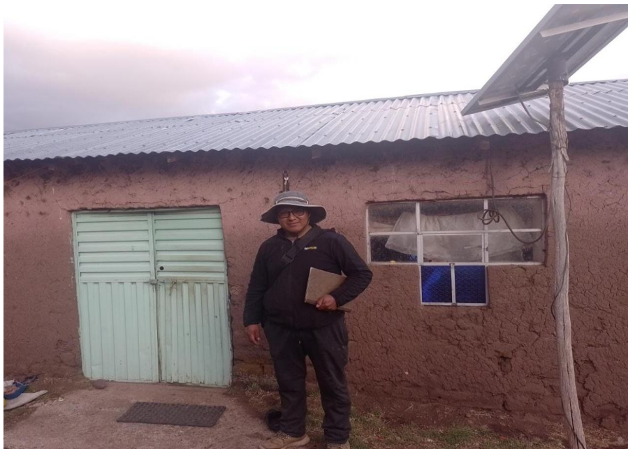
Figura 82. Vivienda construida con pared de adobe y techo de calamina
