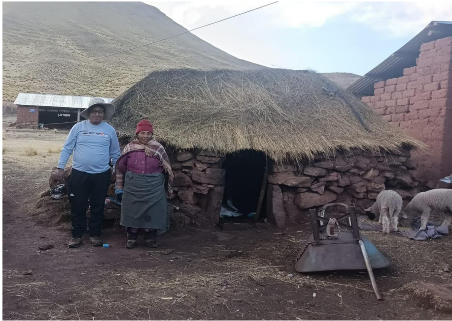
Figura 79. Vivienda construida con pared de piedra y techo de paja
