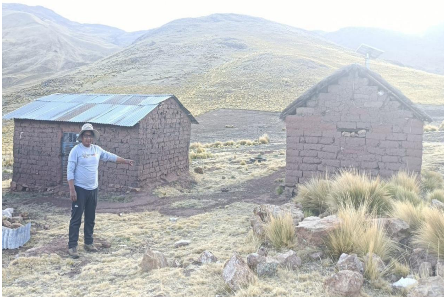
Figura 80. Vivienda construida con pared de adobe y techo de calamina
