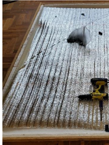
Figura 23: Instalación del aislamiento térmico del módulo Elaborado por el equipo de trabajo.
