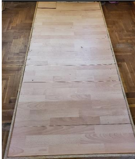
Figura 26: Instalación de suelo de melamina o laminado Elaborado por el equipo de trabajo.
