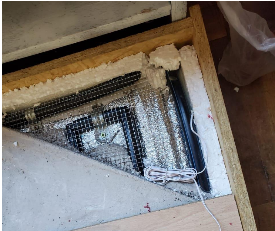
Figura 42: Componentes del módulo de suelo radiante. Fuente: Elaboración propia
