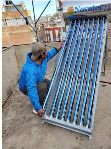
Figura 29: Instalación de Terma Solar Elaborado por el equipo de trabajo.
