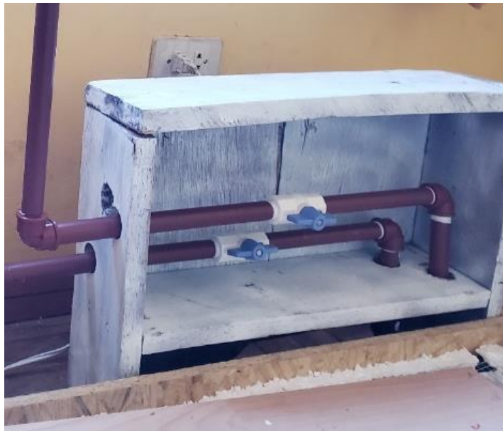
Figura 27: instalación de llaves de entrada y salida de agua caliente Elaborado por el equipo de trabajo.
