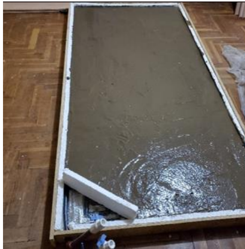
Figura 25: Colocación del mortero de cemento Elaborado por el equipo de trabajo.
