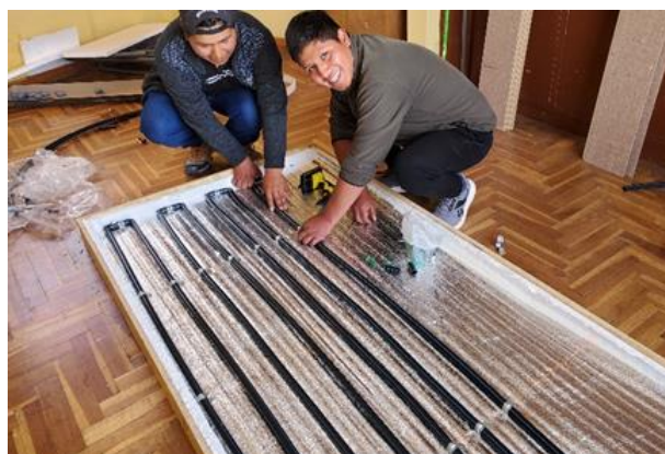
Figura 24: Instalación del serpentín en el módulo Elaborado por el equipo de trabajo.
