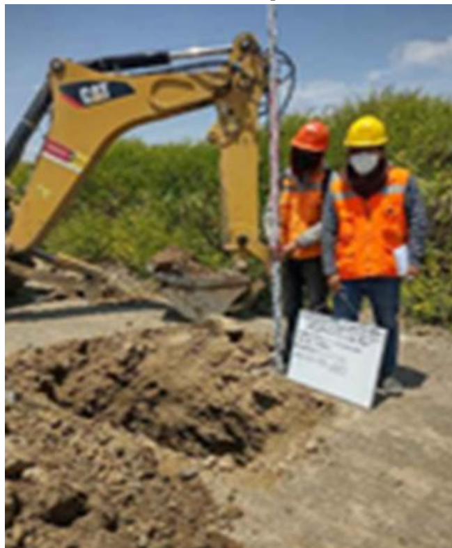
Fotografía 2 Excavación de calicatas en el eje de la carretera en estudio
