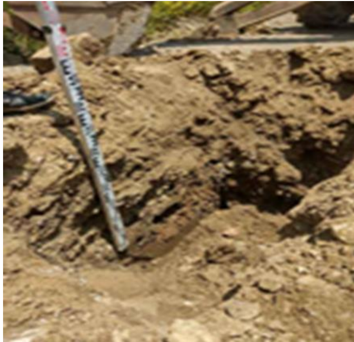
Fotografía 3 Evaluación de estratos de suelos en el terreno de fundación
