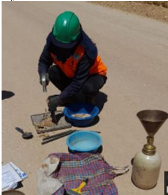
Fotografía 1 Control de densidad de campo in situ , método cono de arena
