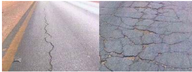
FIGURA III.19: Muestra algunos patrones de agrietamiento por fatiga que se desarrollan en la carpeta asfáltica.
