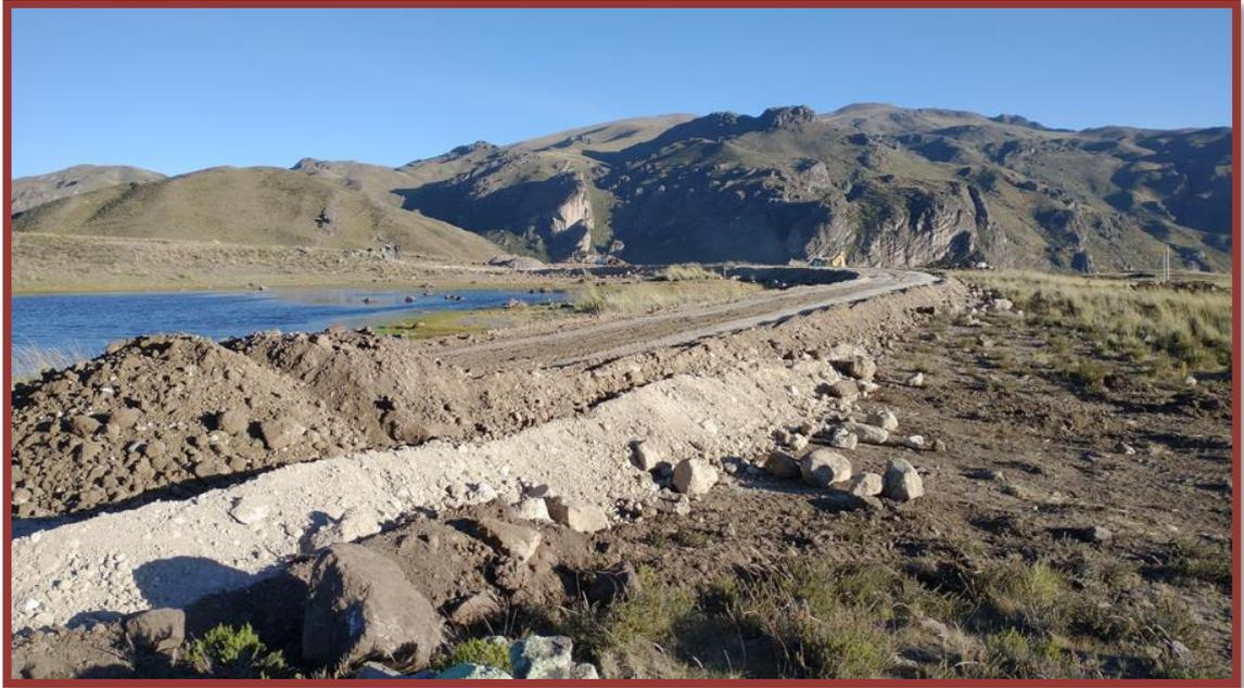
En la imagen se aprecia el relleno compactado con material de préstamo.
