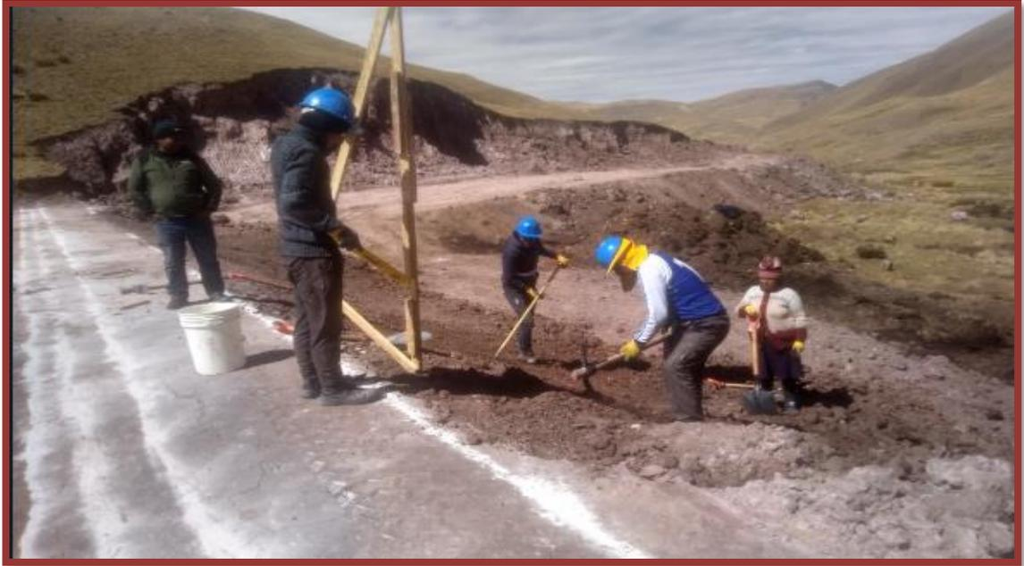
En la imagen se aprecia el perfilado y refine de talud.
