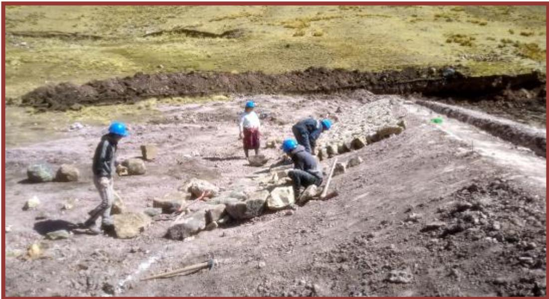
En la imagen se aprecia el perfilado y refino de talud.
