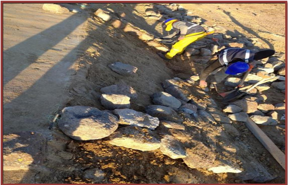
En la imagen se aprecia el perfilado y refino de talud.
