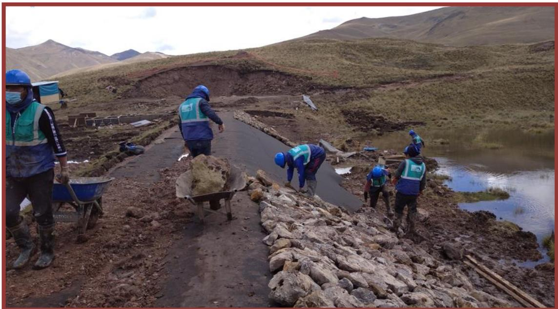
En la imagen se aprecia la conformación de espaldón con piedra.
