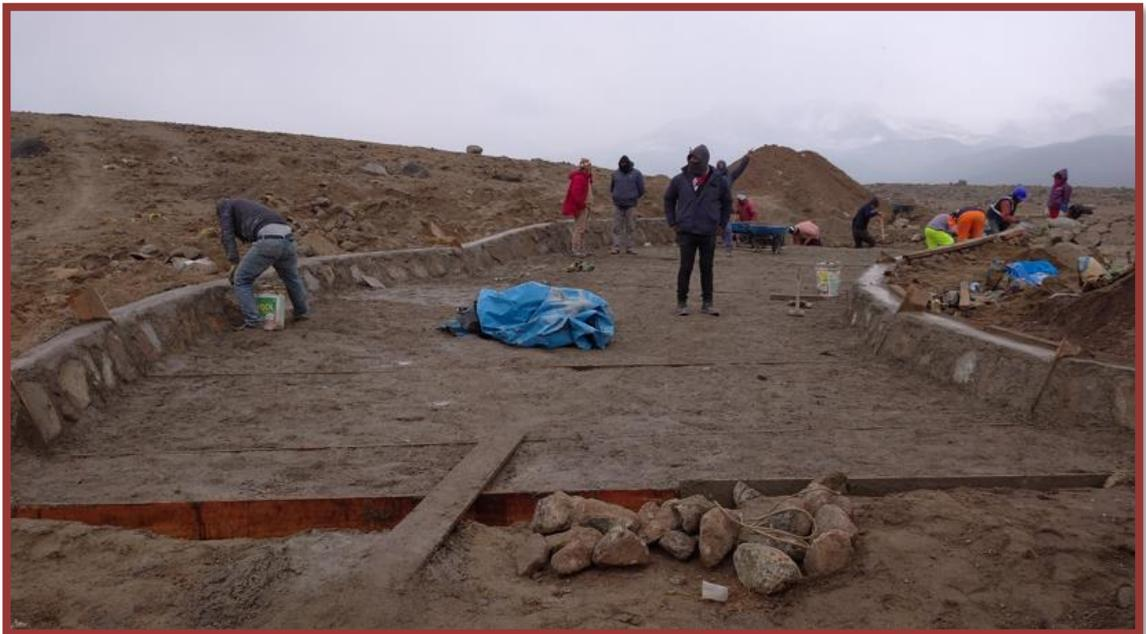
En la imagen se aprecia el asentado de piedra en concreto  $f_c=210 \text{ kg/cm}^2$ .
