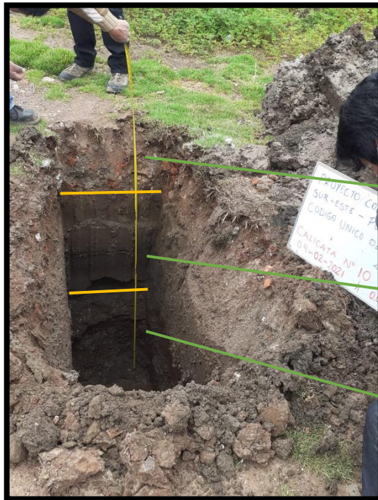
FIGURA 33: Corte transversal de la calicata 10. Fuente: Elaboración propia).
