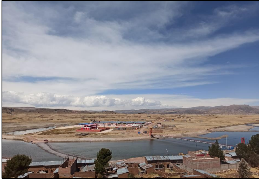
Figura 20. Red de Drenaje.
