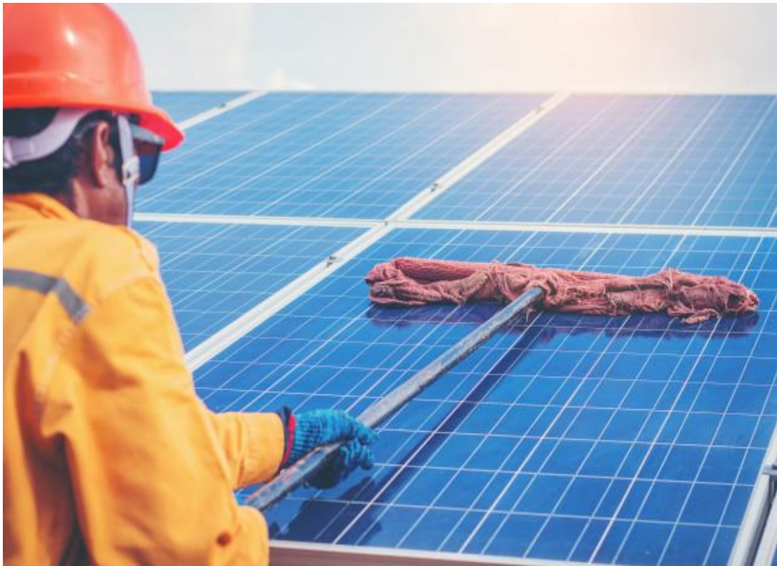
Figura 7: Limpieza de paneles solares fotovoltaicas Fuente: Inntecsol.com
