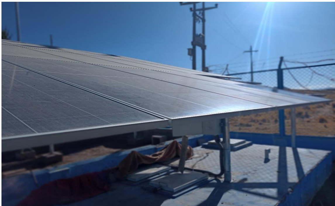
Paneles solares monocristalinos con acumulación de polvo
