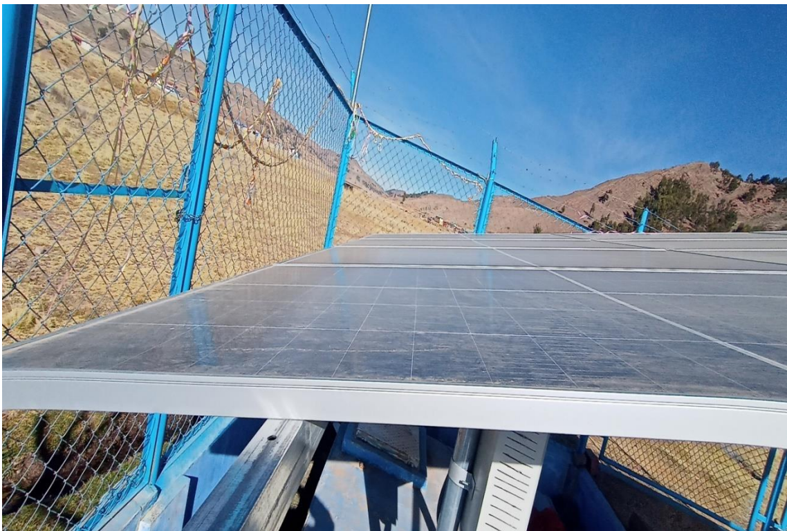
Paneles solares monocristalinos con acumulación de polvo
