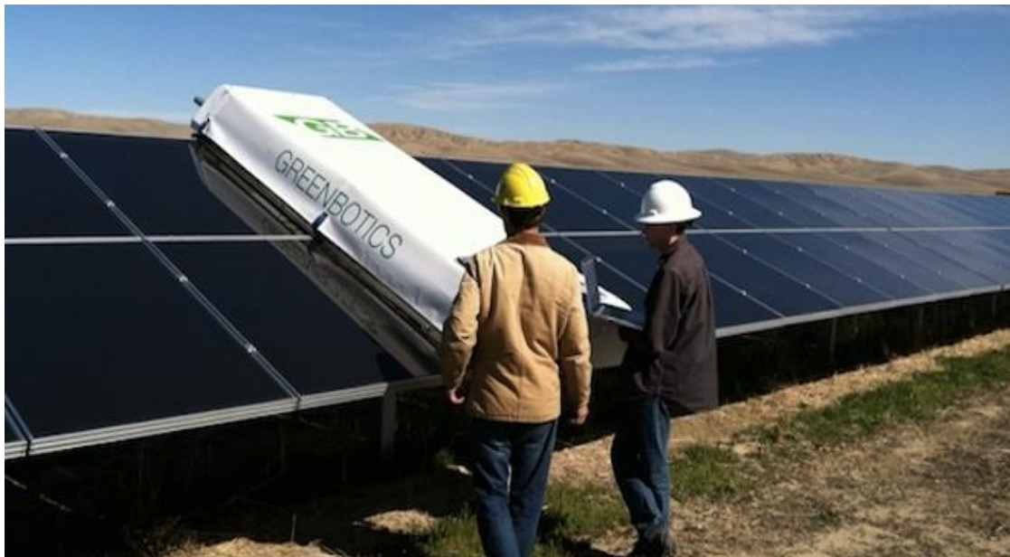
Figura 8: Limpieza de paneles solares automáticos Fuente: Inntecsol.com
