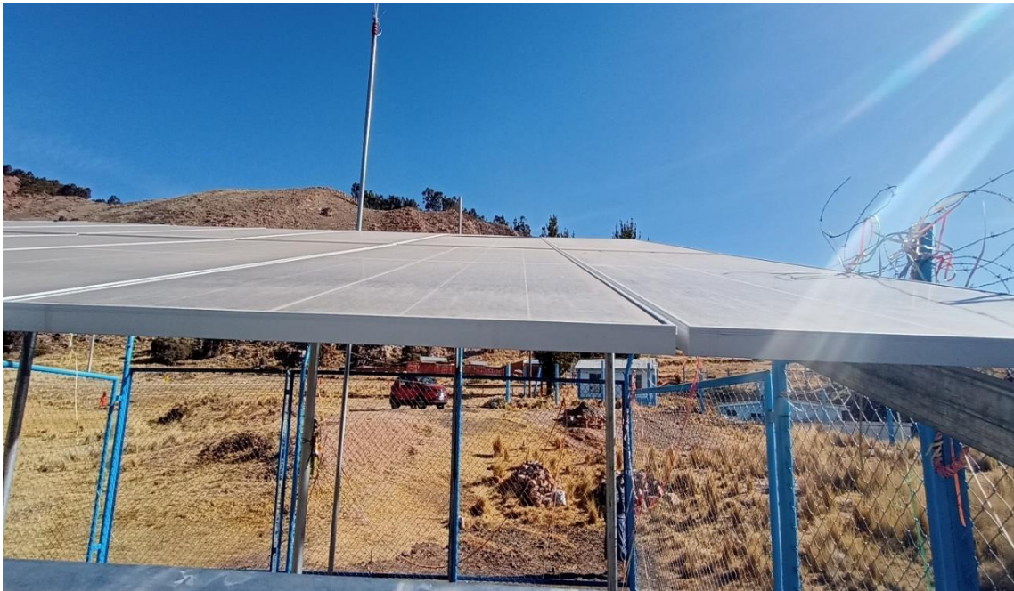
Paneles solares monocristalinos con acumulación de polvo
