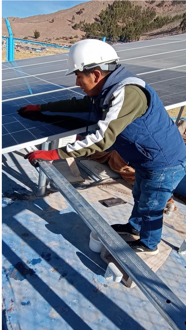
Figura 13: Celda fotovoltaica con limpieza periódica Elaboración propia
