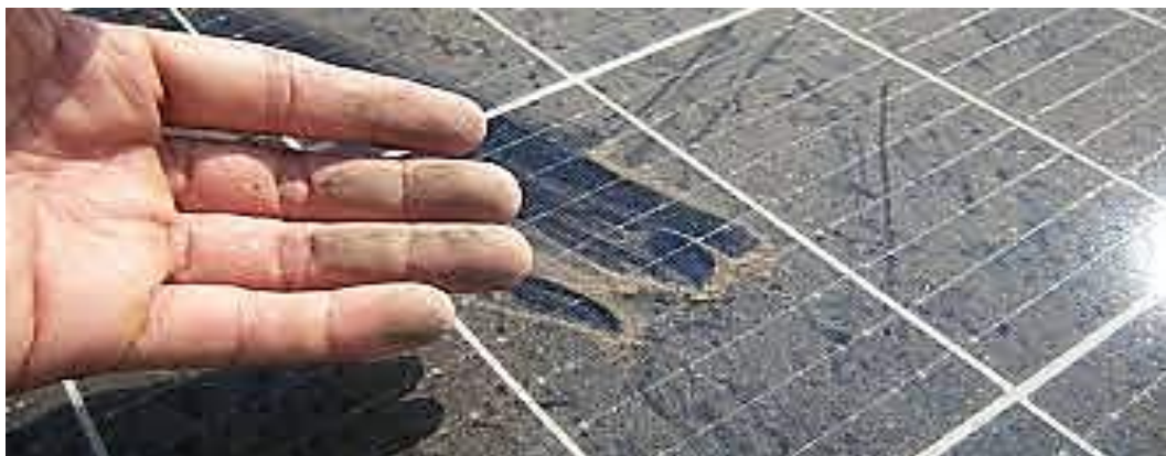
Figura 2: Polvo en paneles solares. Fuente: Info@engi.co
