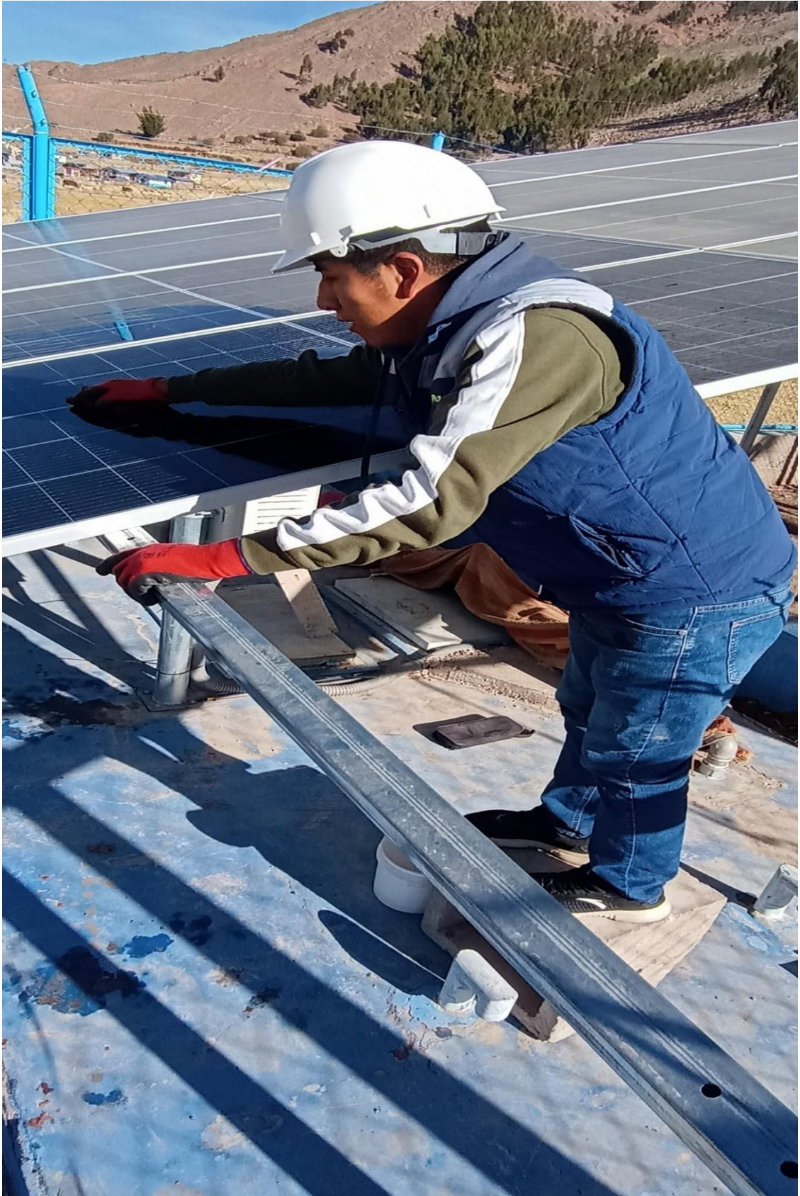
Limpieza de paneles solares monocristalinos
