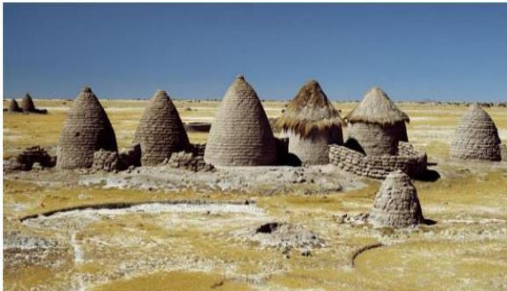
Nota: El t'epe la unidad constructiva es un bloque de tierra con raíces, de dimensiones: 0.43 m x 0.40 m x 0.12 m. Existen dos tipos de viviendas: las de forma "de colmena", y las de base circular, pero con techo de paja y sostenido por arcos de caña. (Gamio, 2018).
