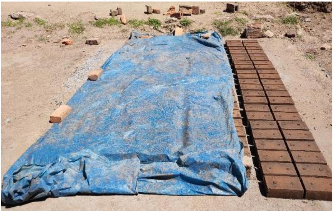
**Nota:** Se protegieron los bloques con plástico, pues la presencia de cemento en los bloques podría producir fisuras en la superficie debido al shock térmico.
