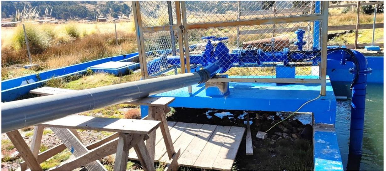
**Figura 20.** Vista del equipo de impulsión
