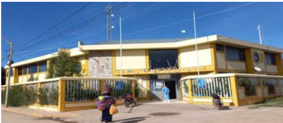
Figura 3. Vista frontal del Centro de Salud Taraco.
