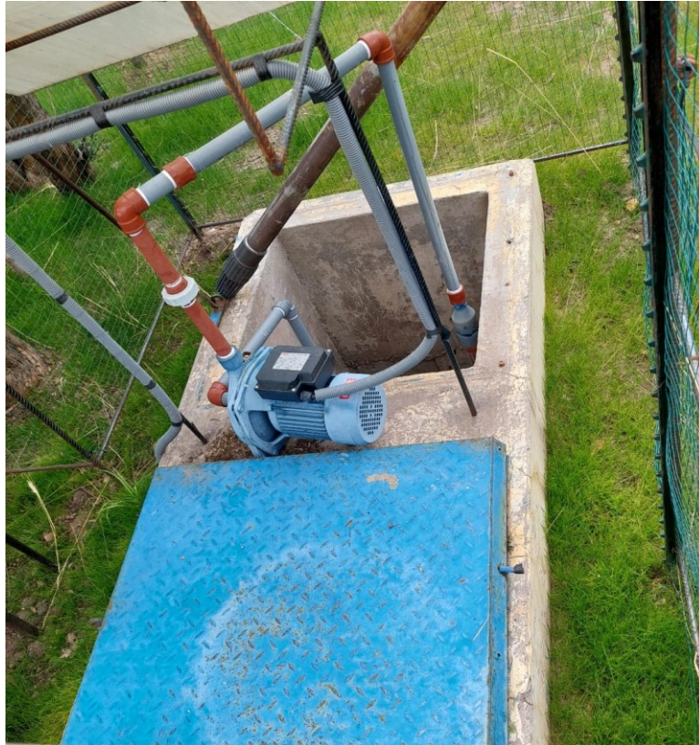
Primer punto de monitoreo – pozo PM01
