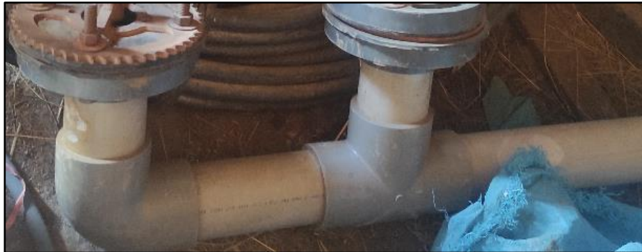
Construcción del cuerpo de la bomba
