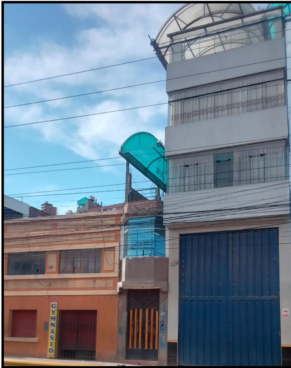
Figura 19: La edificación de la Av. Floral N° 453 Vivienda incumple el área de techado mínimo según el artículo 8 Norma A.020 del RNE
