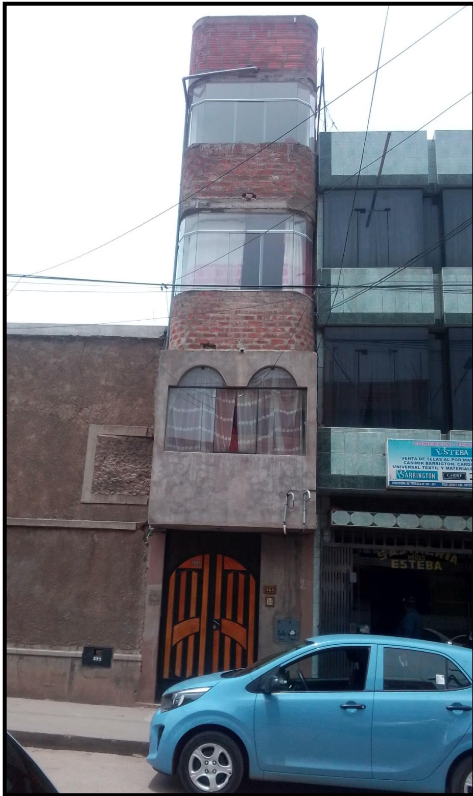
Figura 7: Vista frontal de la edificación familiar en la Av. Titicaca N°235
