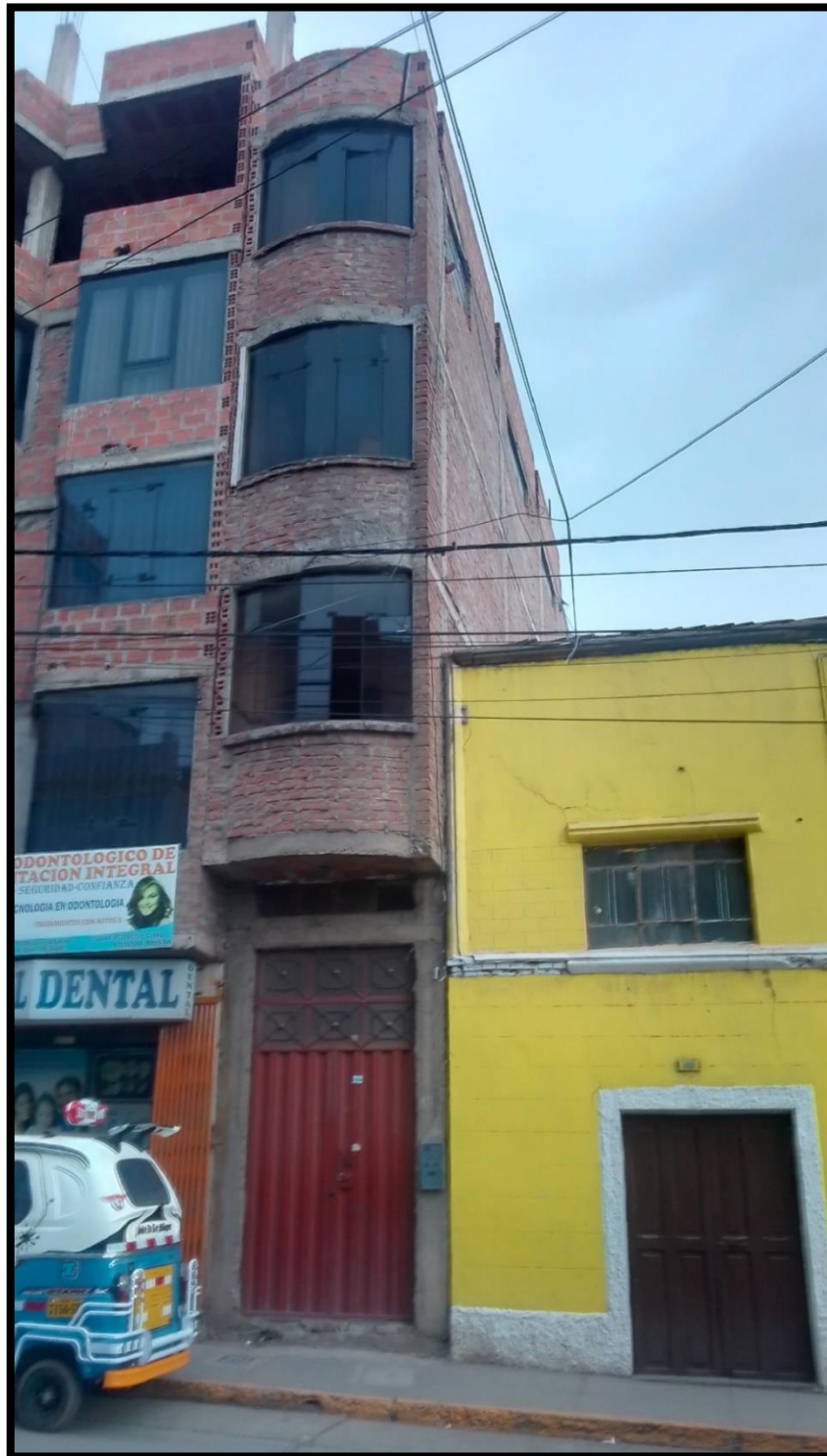
Figura 6: Vista lateral de la edificación delgada en el Jr. Echenique N° 113
