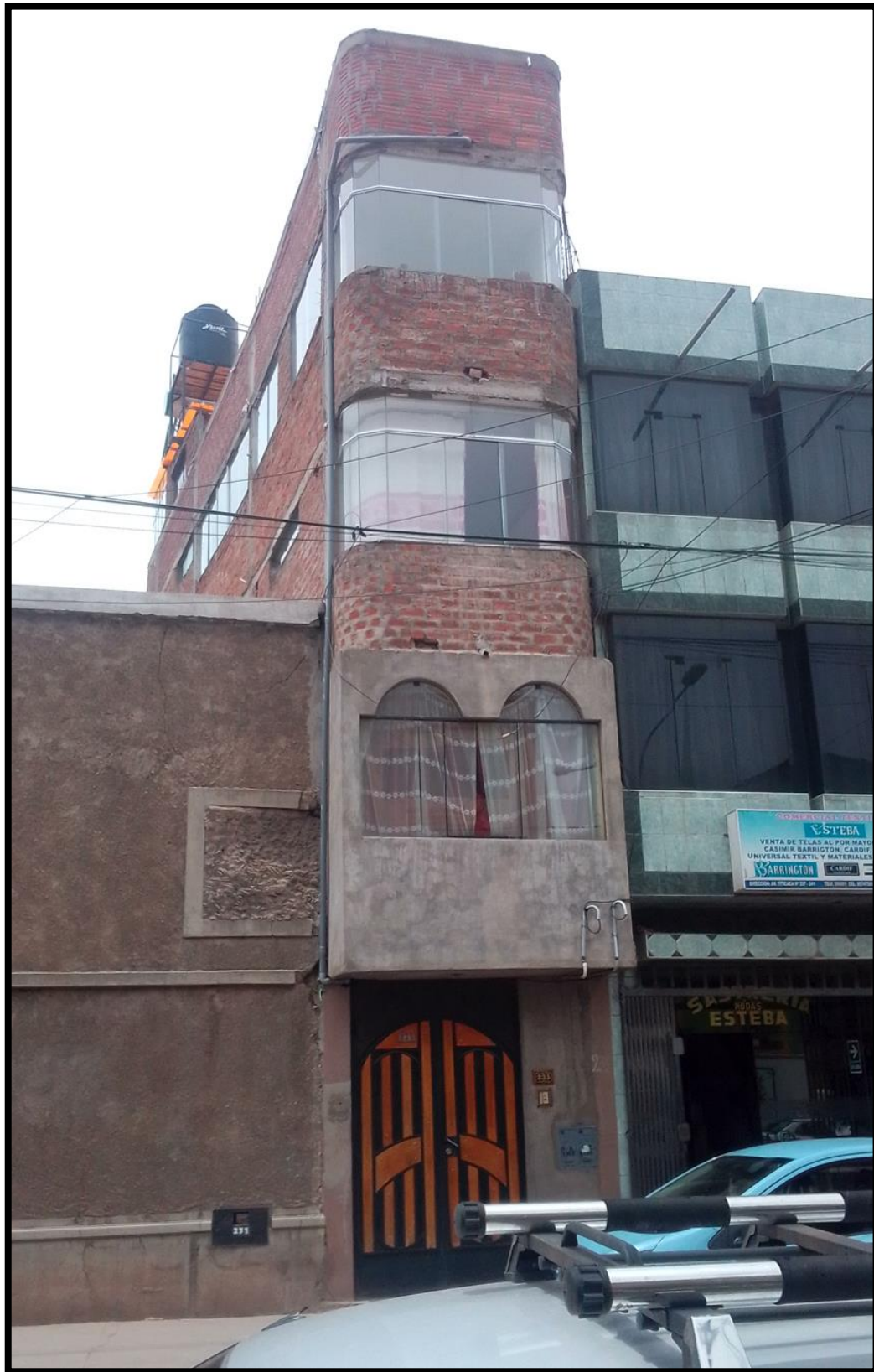
Figura 8: Vista lateral de la edificación familiar en la Av. Titicaca N°235
