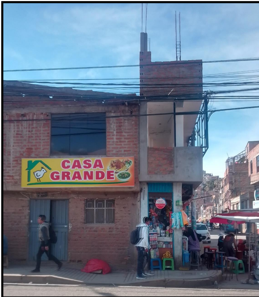
Figura 11: Vista frontal de la edificación en la esquina de los jirones Los Incas y Jirón Andahuaylas S/N
