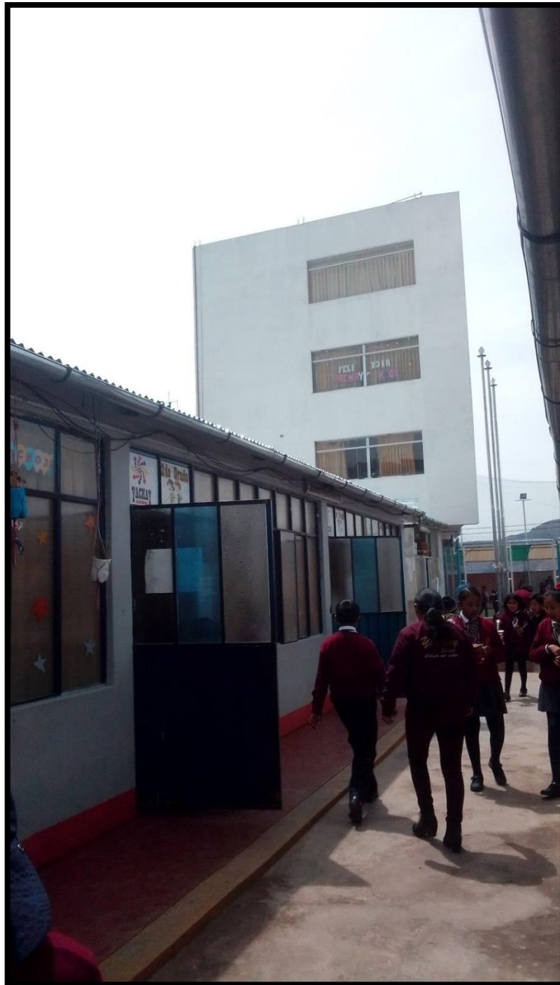
Figura 15: Vista delantera de la edificación en la Av. Floral N° 940 que tiene un ancho de su patio que disminuye hasta menos de 2 metros.
