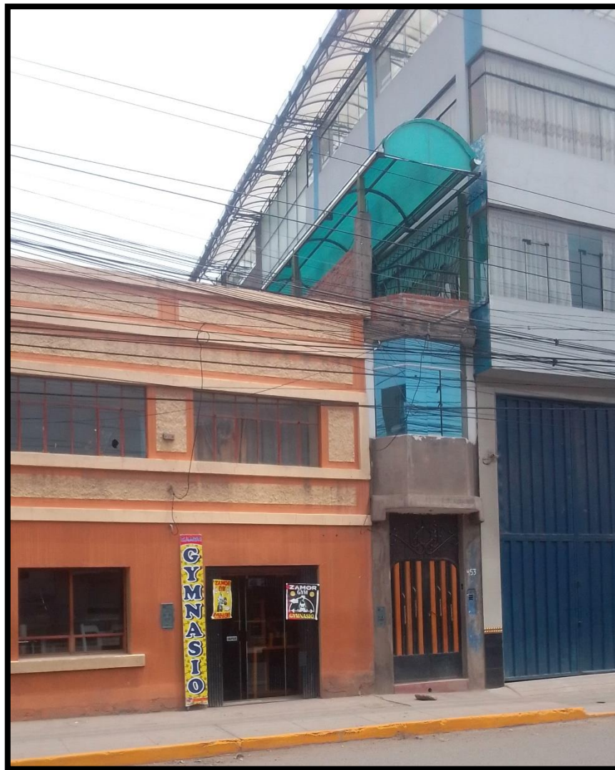
Figura 20: Vista lateral de la edificación en la Av. Floral N° 453 que evidencia la falta de Seguridad y Habitabilidad Vivienda.
