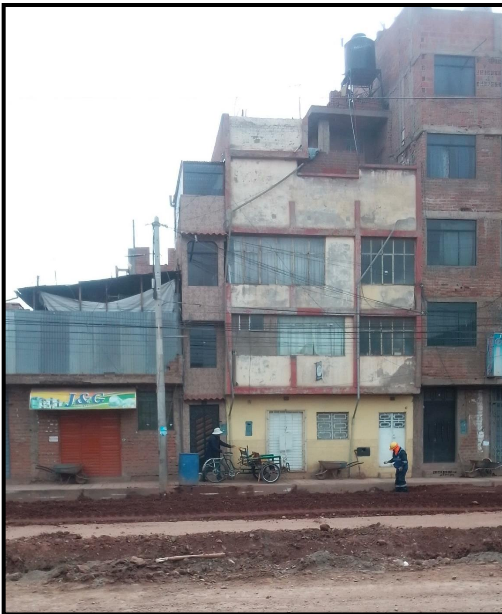
Figura 9: Vista frontal de la edificación en la Av. Simón Bolívar N°577
