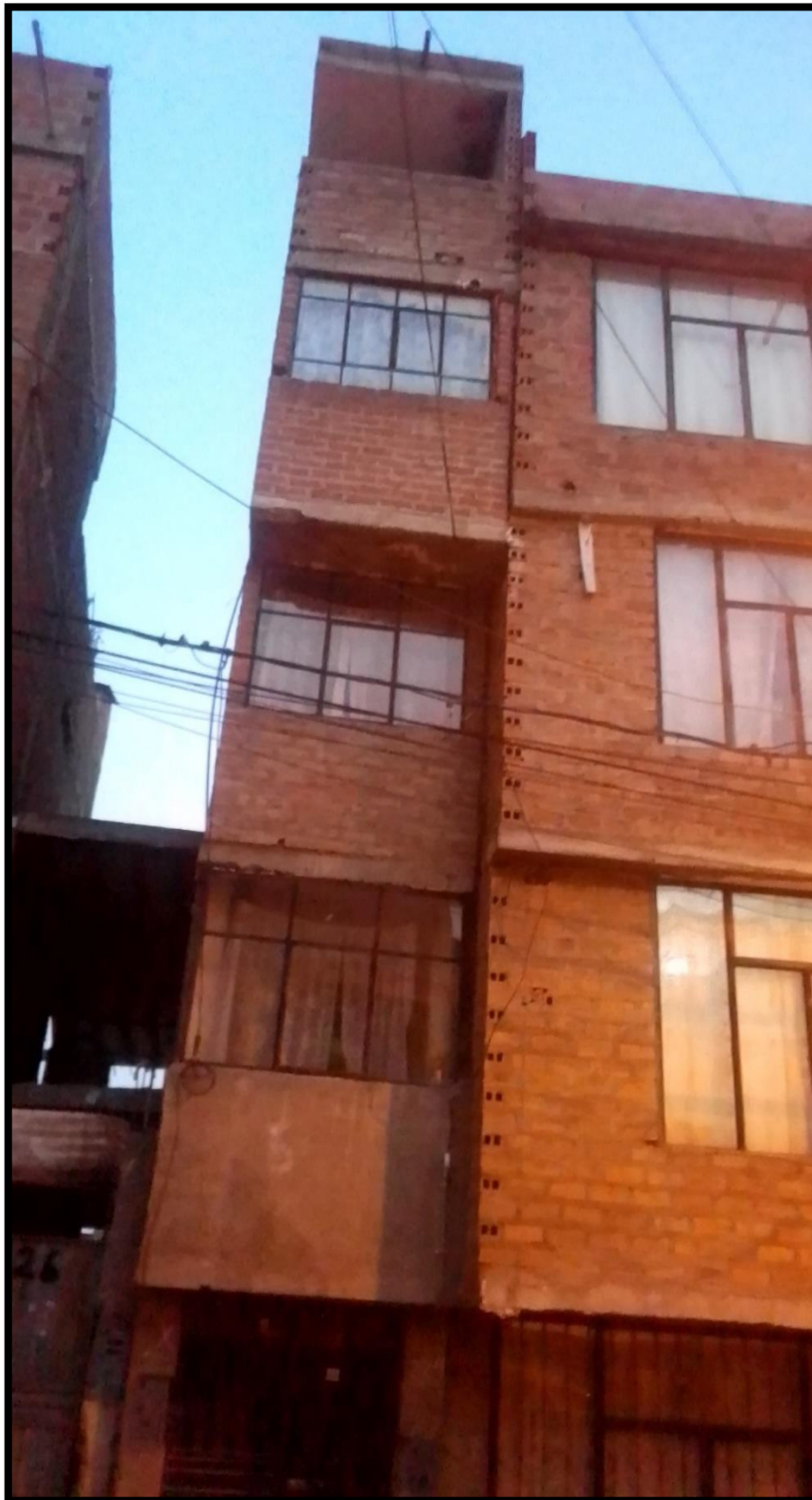
Figura 21: Vista frontal de la edificación en el Jr. Junín N° 224
