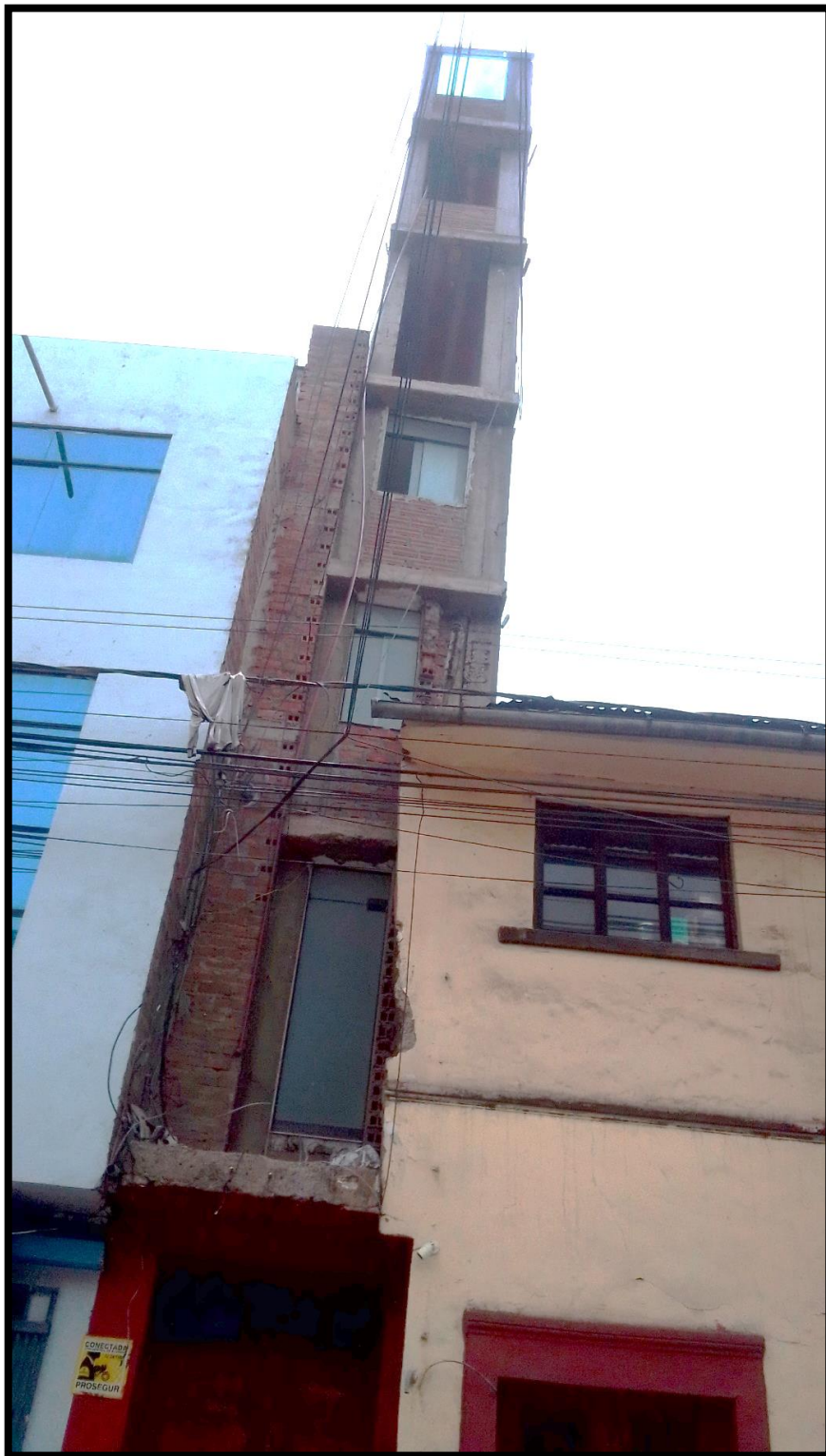
Figura 3: Vista frontal de la edificación del Jr. Moquegua 442 en la cual el primer nivel es de uso comercial y la restante vivienda
