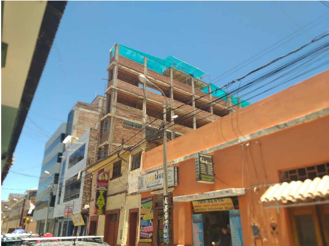
Figura 26: Vista lateral de la edificación del Jirón Moquegua 442 que muestra una continuidad en su ancho
