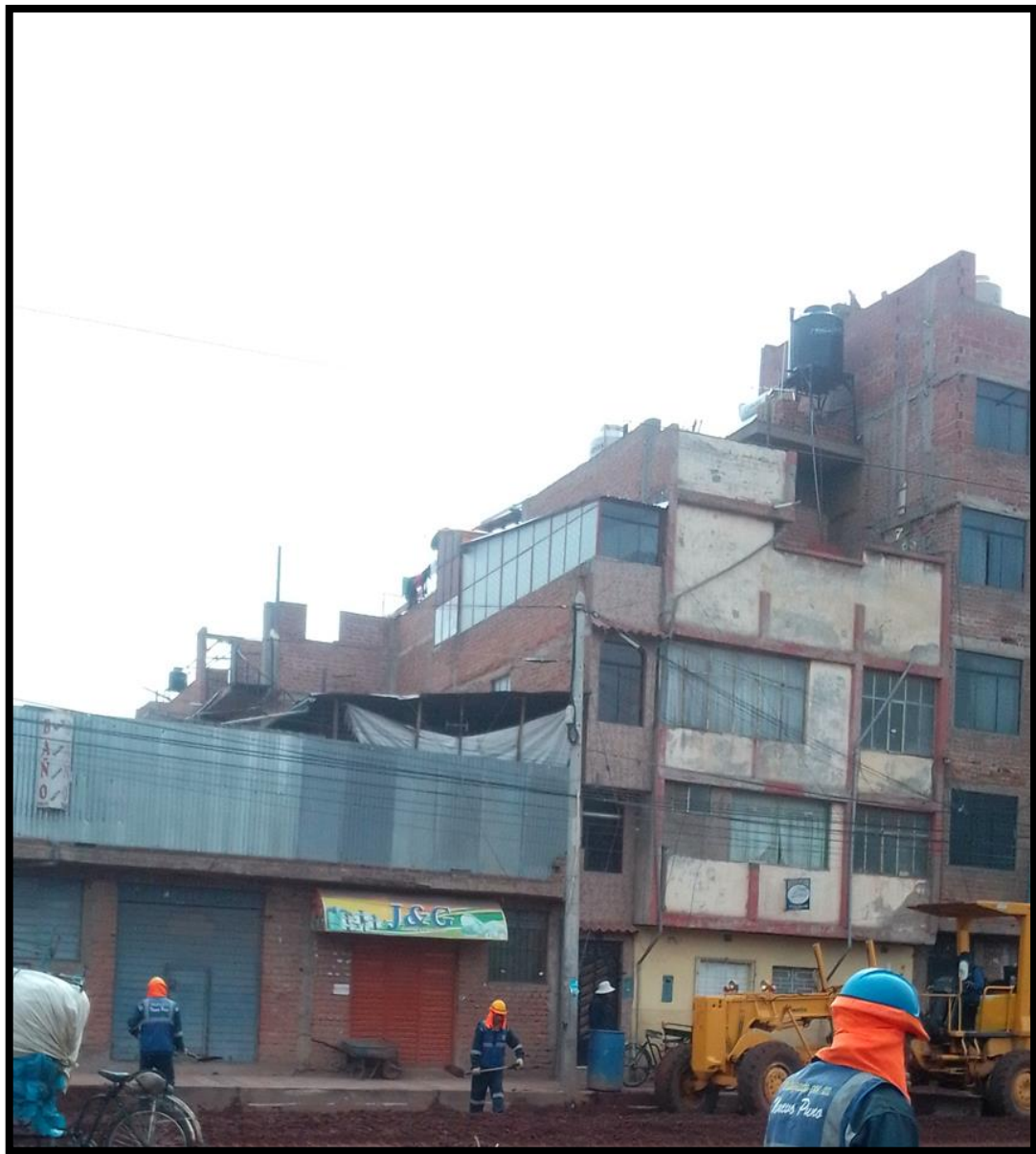
Figura 10: Vista lateral de la edificación en la Av. Simón Bolívar N°577
