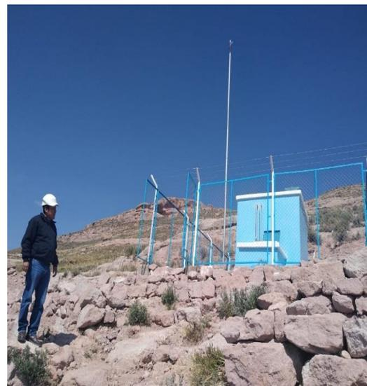
**Comentarios:** En las imágenes apreciamos los trabajos de restauraciones de impactos en reservorio, como estabilización física de talud, tipo terraplenado con piedras en la base, trabajo realizado con fines de evitar impacto alguno y nivelación alrededor de paneles solares y reservorio.
