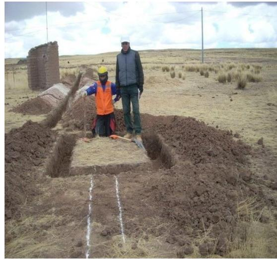
**Comentarios:** En las imágenes apreciamos los trabajos de seguimientos y control de impactos, en los trabajos de remoción de zanjas por los trabajadores del proyecto, donde se recomienda el apilamiento adecuado de la tierra, con fines de evitar erosiones.
